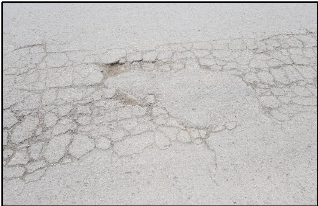
Figura 7. Falla por cocodrilo
