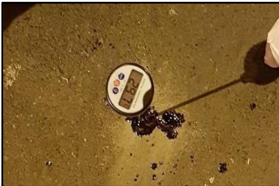
Figura 21. Colocación de aceite al agujero de 10 cm para medir la temperatura al pavimento
