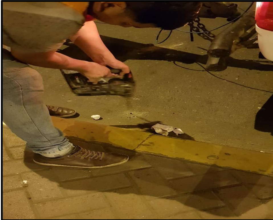
Figura 19. Perforación del pavimento.
