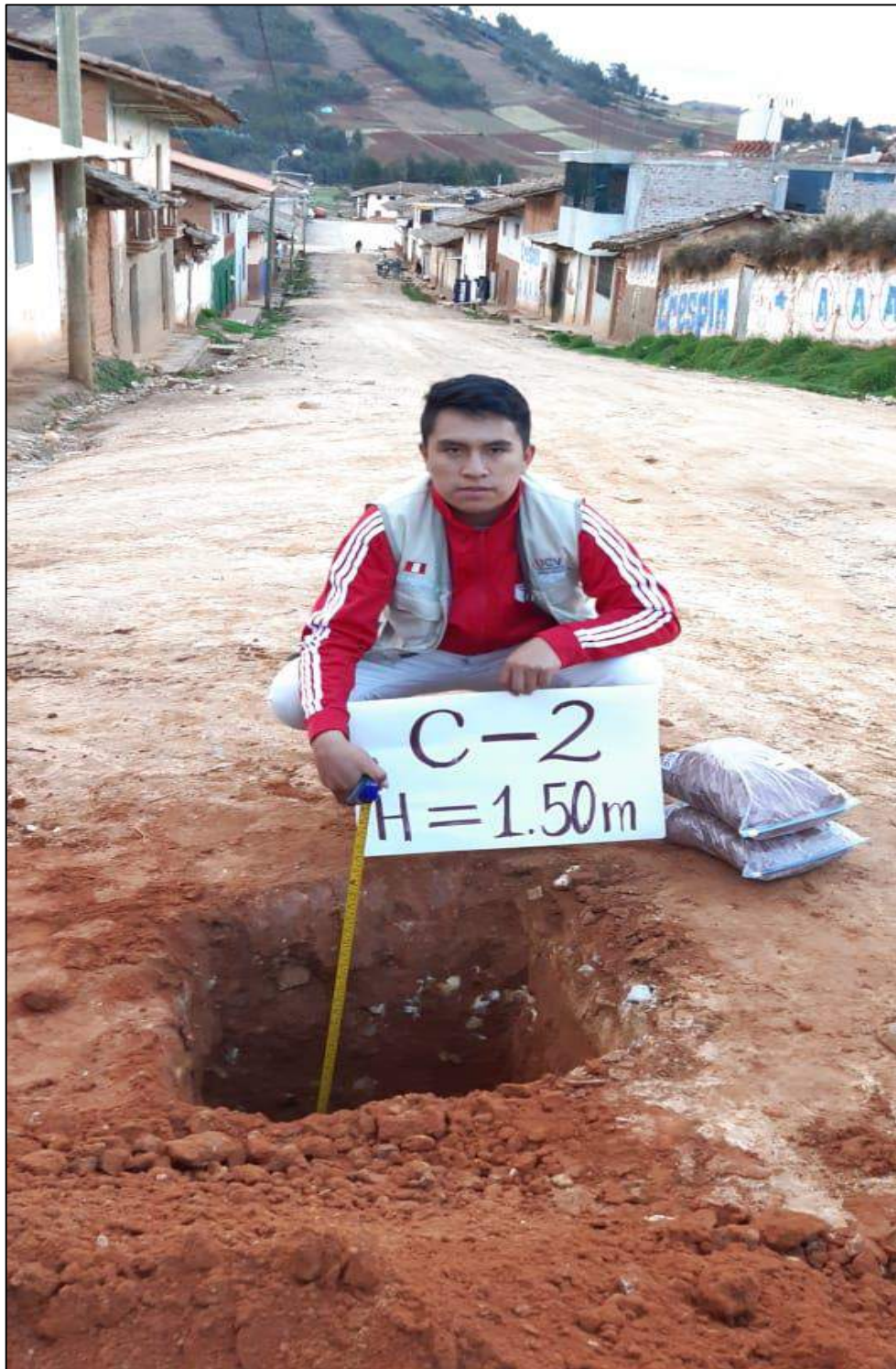
FOTOGRAFÍA N° 14: Se aprecia la recolección de muestra en la calicata C-2, ubicada entre la Av. San Pedro y la Calle San Martín.
