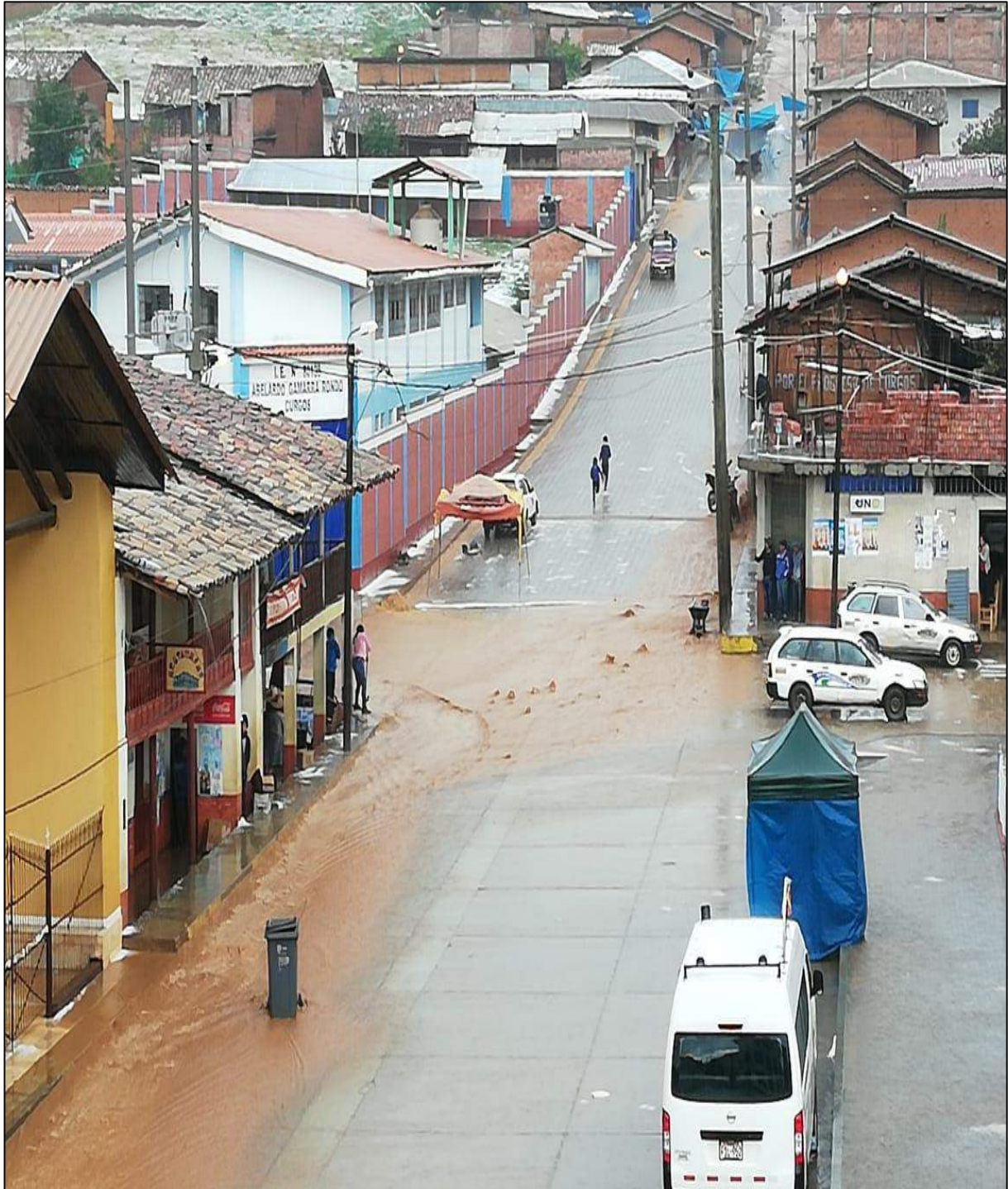
FOTOGRAFÍA N° 06: Se puede observar la escorrentía en la Plaza de Armas de la Localidad de Curgos, que es producto de la acumulación de aguas lluvias que conduce la Av. Manuel Prado.
