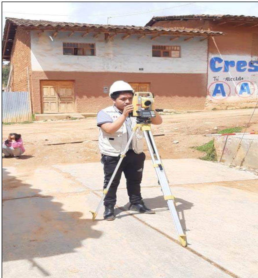
FOTOGRAFÍA N° 13: Se observa la toma de datos con la estación total top con es-105 en el Pasaje Juan Velasco Alvarado de la Localidad de Curgos.
