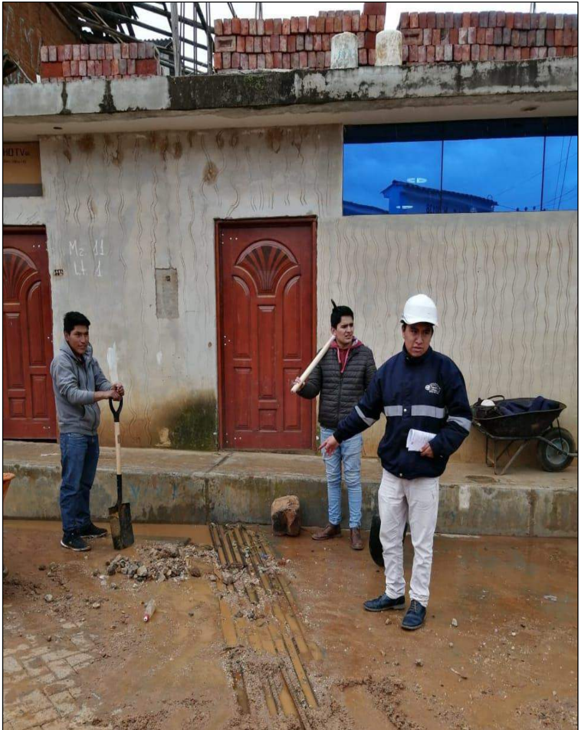
FOTOGRAFÍA N° 09: La escorrentía superficial de la Av. Manuel Prado, genera obstrucciones en los sistemas convencionales existentes e impide la evacuación de agua acumulada.
