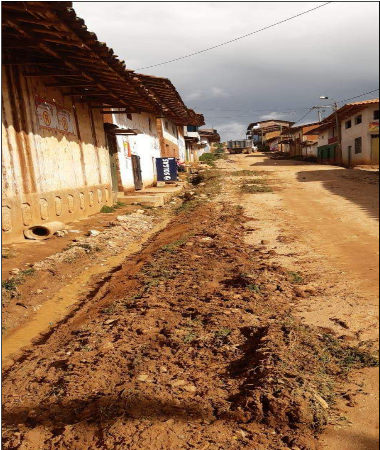
FOTOGRAFÍA N° 05: La inexistencia de un sistema para evacuación de aguas lluvias genera la necesidad de realizar continuamente limpieza en cunetas existentes.
