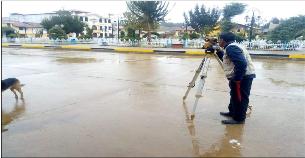
FOTOGRAFÍA N° 10: Se aprecia la toma de datos con la estación total top con ES-105, ubicado en la plaza de armas de la Localidad de Curgos.
