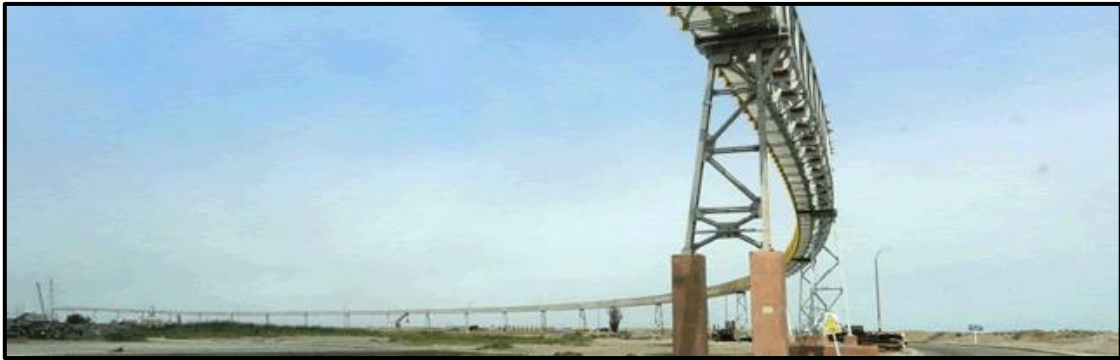
Figura 15. Tramo de la faja transportadora
