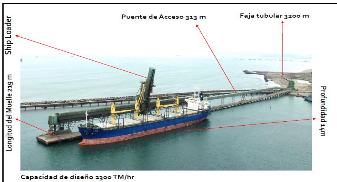
Figura 27. Etapa Única del Terminal Embarque de Concentrados de Minerales en el TP Callao
