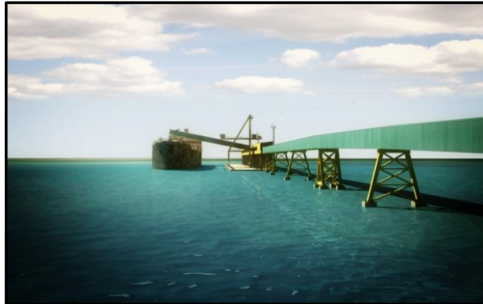
Figura 12. Faja Tripper, Shiploader y Muelle de Minerales
