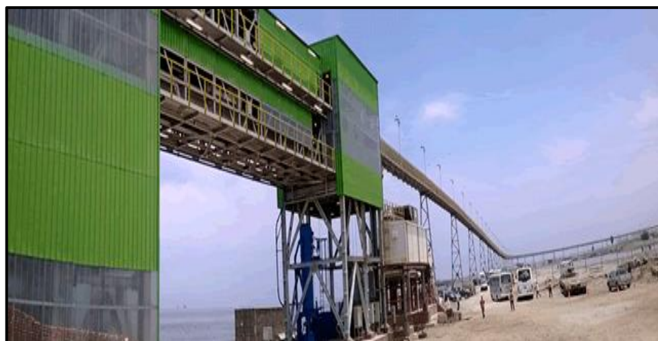
Figura 11. Edificio de transferencia
