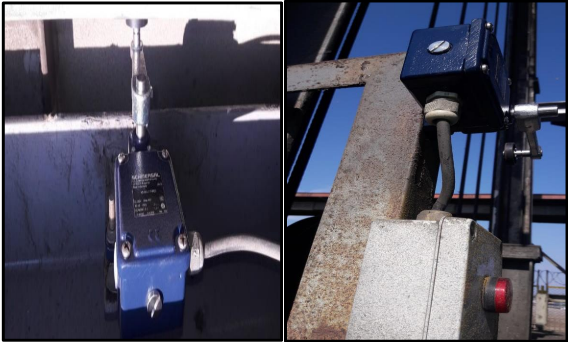
Figura 46. Mantenimiento de finales de carrera para regular contrapeso – Después 3 y 4
