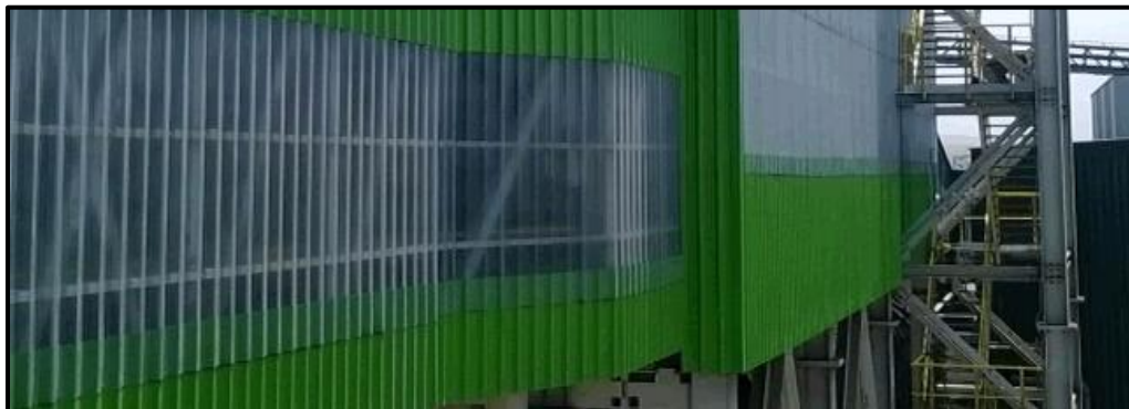
Figura 16. Caja de recepción de concentrados de minerales
