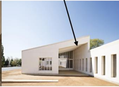
Abertura perforada vista desde el exterior
