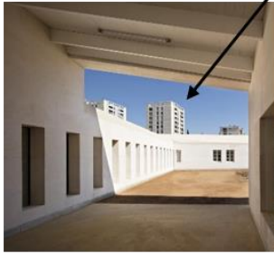
Abertura perforada vista desde el interior
