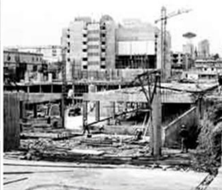
Construcción del Centro Cívico- 1969
