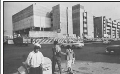
Centro Cívico, en construcción
