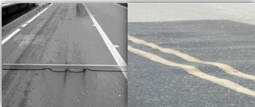
**Figura 2.** Deformación permanente a nivel de carpeta asfáltica
