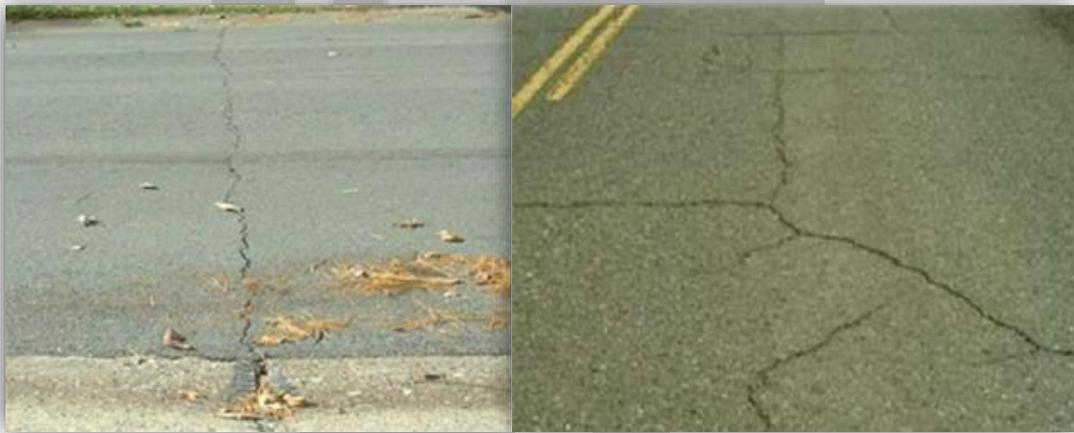
**Figura 4.** Fisuración por baja temperatura
