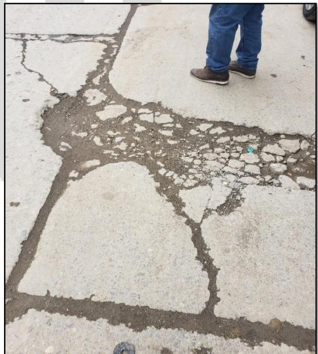
**Fotografía 38 y 39.** Problemática en la durabilidad y resistencia de los pavimentos a climas de zonas de altura en las vías de ciudad de Cerro de Pasco, Provincia de Pasco, Departamento de Pasco.
