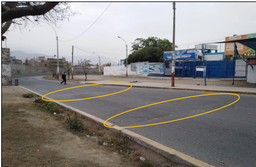
Figura 37. Situación actual de las gibas existentes.
