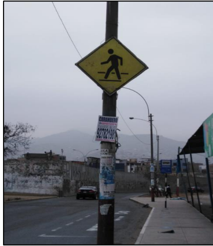
Figura 36. Situación actual de las señales verticales.
