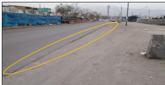
Figura 35. Situación actual de la vía en la UNMSM.
