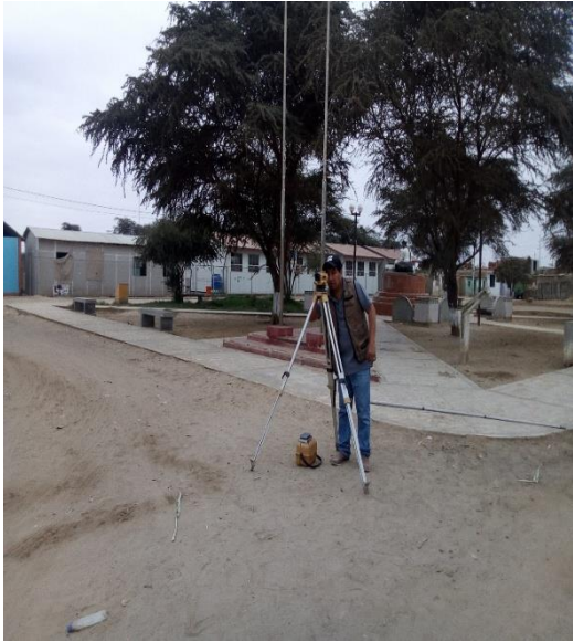
Foto N° 6: levantamiento topográfico de las calles del caserío santa Isabel.
