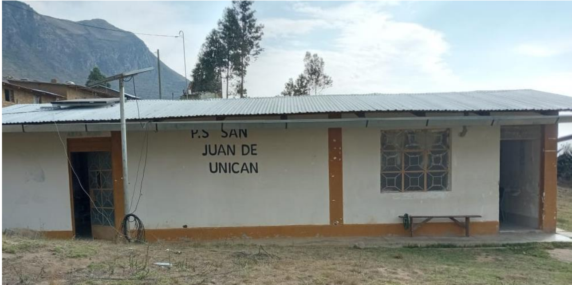
Figura 4: Vista Puesto de Salud San Juan de Unican
