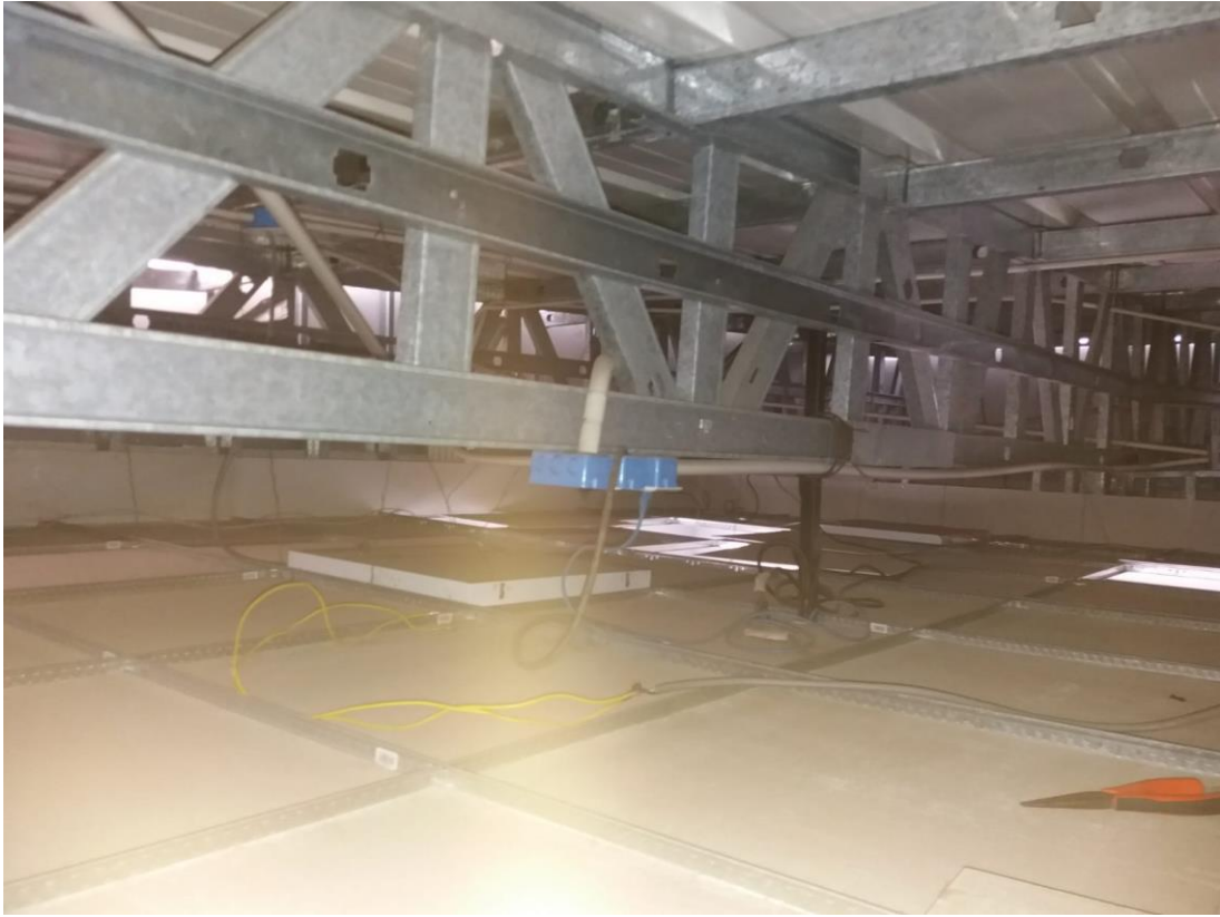
Anexo 28. Montaje de canaletas para protección de los circuitos de iluminación y de detección
