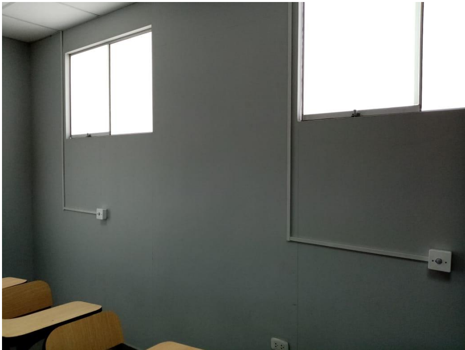
Anexo 28. Montaje de canaletas para protección de los circuitos de iluminación y de detección
