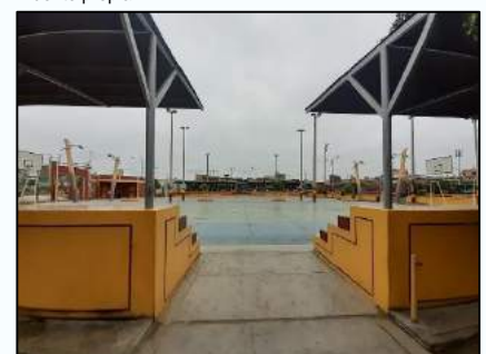
VISTA 2 (Hacia Losa multideportiva) Fuente propia
