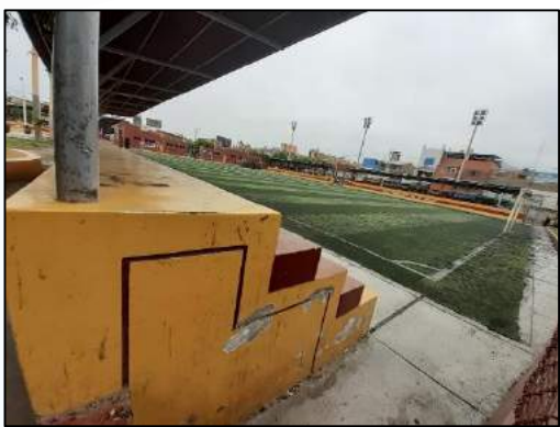
VISTA 3 (Hacia campo de futbol) Fuente propia
