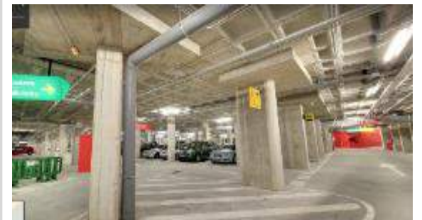
VISTA AL INTERIOR DEL ESTACIONAMIENTO FUENTE: ARCHDAILY
