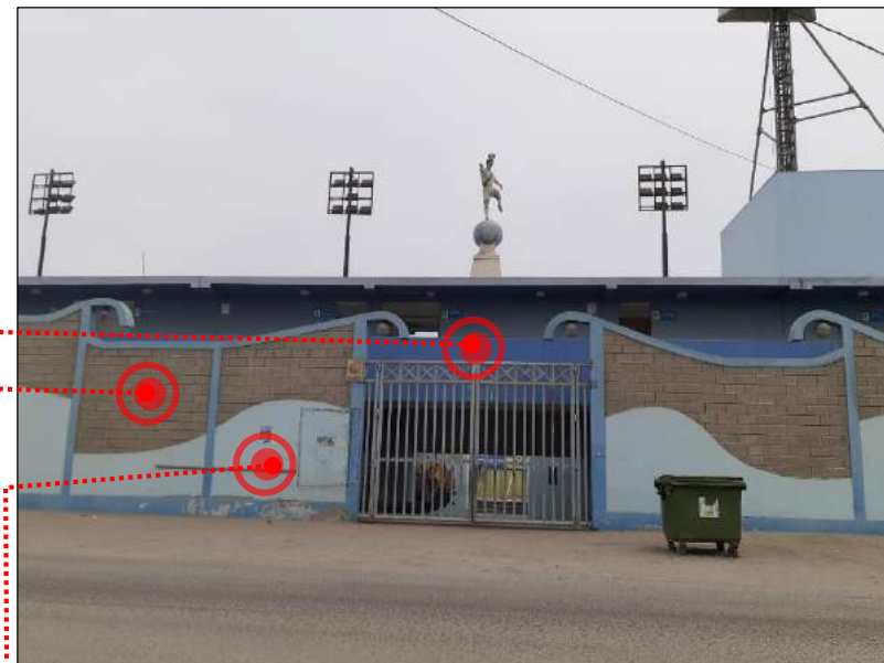
Por Av. Central, (Fuente. propia)
