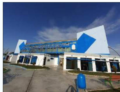
VISTA 1 (Hacia Coliseo Cerrado) Fuente propia
