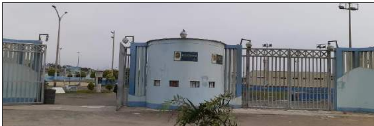
Por Av. Central – Ingreso Estacionamiento (Fuente. propia)
