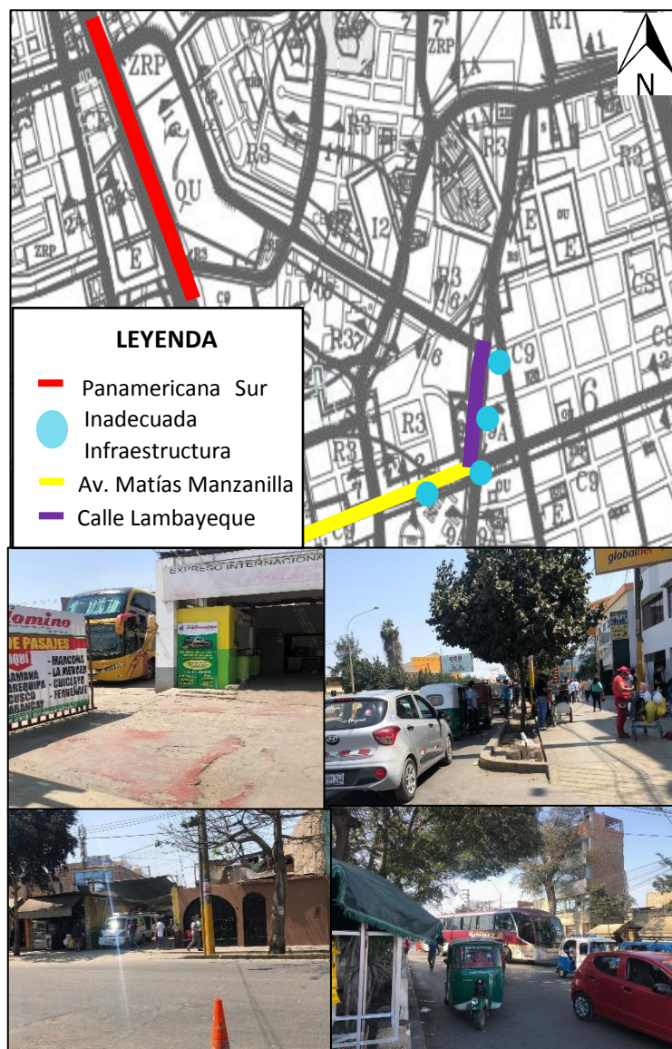
Figura 37: Infraestructura de vías en mal estado
