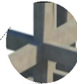
UNIÓN ENTRE VIGAS Y COLUMNAS
