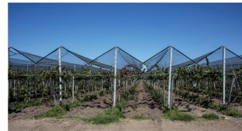
Soporte estructural que protege a la planta
