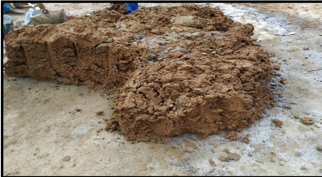
FOTO N°02: Se observa el material para la mezcla de manera manual, ayudándose de herramientas manuales.
