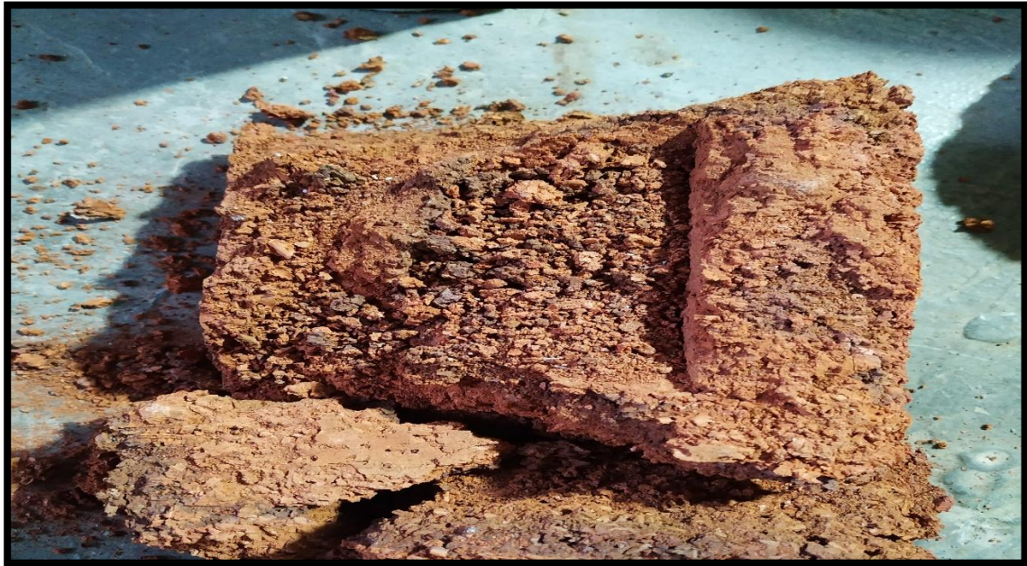
FOTO N°12: Se observa que el ladrillo al 50% no logro estar en un buen estado por ende dificultara hacer los ensayos propuestos.
