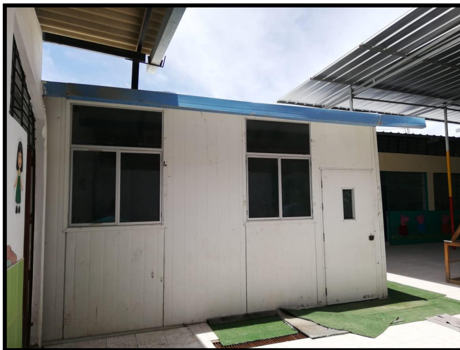
Foto N° 21 y 22: Vista del aula prefabricada en regular estado de conservación.
