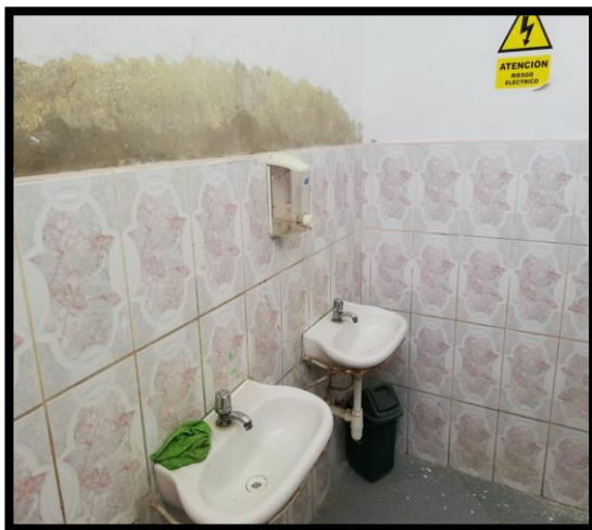
Foto N° 25 y 26: Vista del interior de los servicios higiénicos, se verifica el desgaste de los materiales de acabados.
