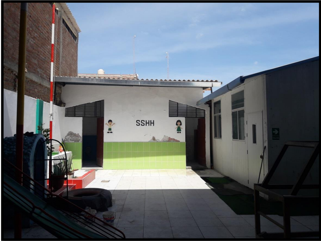
Foto N° 24: Vista elevación del pabellón E.
