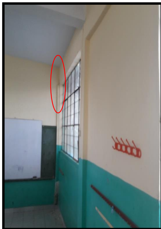
Foto N° 08 y 09: Vista del primer nivel donde no se ha seguido con la misma sección de columna, esto afecta estructuralmente la edificación y pone en riesgo la integridad de los estudiantes.
