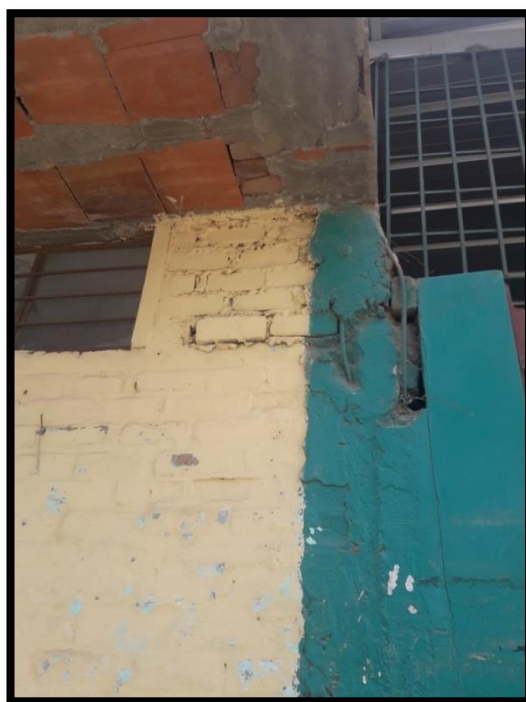
Foto N° 08 y 09: Vista del primer nivel donde no se ha seguido con la misma sección de columna, esto afecta estructuralmente la edificación y pone en riesgo la integridad de los estudiantes.
