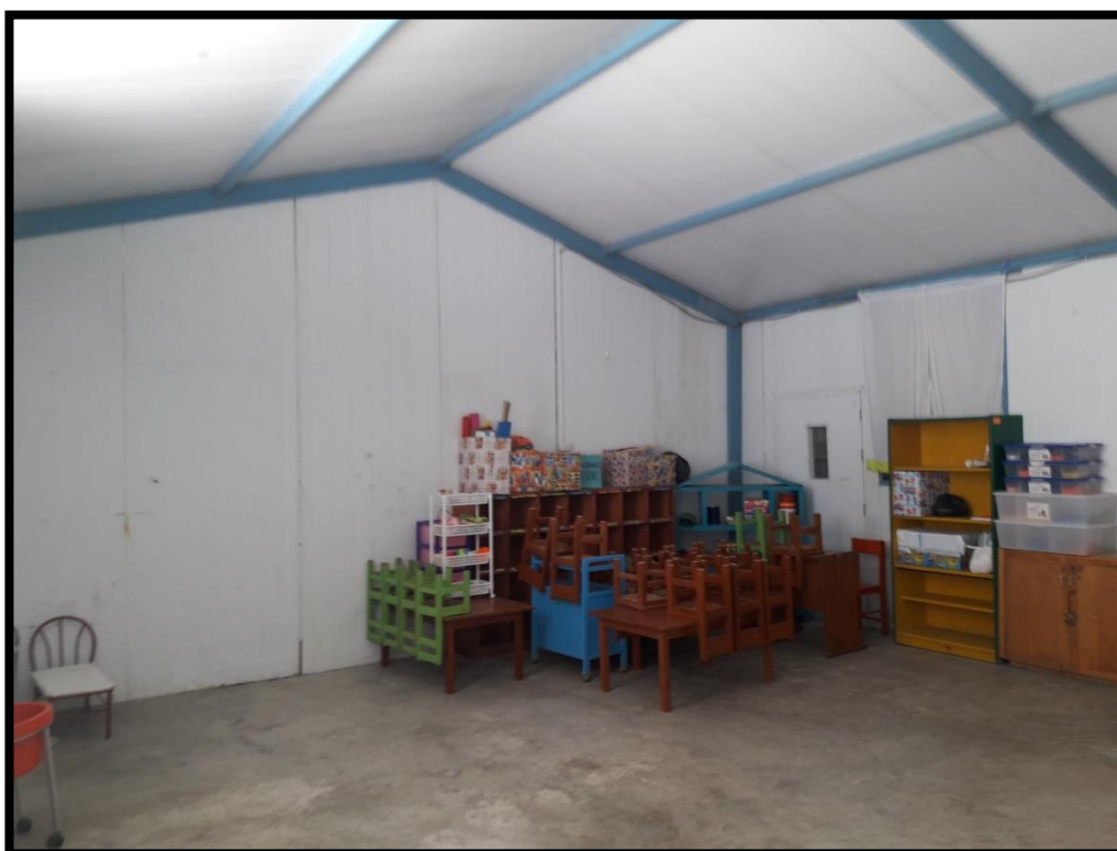
Foto N° 23: Vista del aula prefabricada en su interior con una antigüedad de 5 años.
