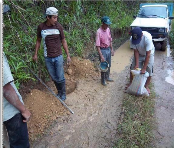
Imagen 18: Proceso de excavación de la Calicata.
