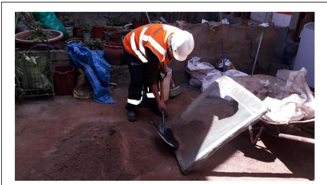
Figura 23. Proceso a seguir de elaboración de los ladrillos de tierra cruda comprimida
