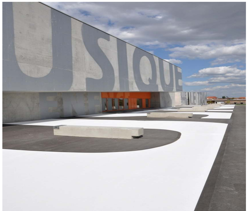
Fig. 05: Vista exterior del Conservatorio
