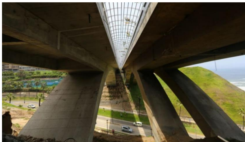
Figura 4. El puente Villena y su Mellizo Villena Rey 2016.
