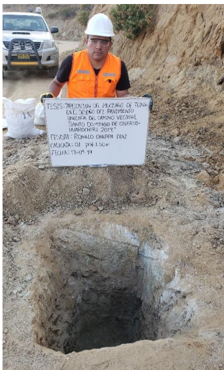
Foto N°4. Excavación de Calicata N°1 con una profundidad de 1.50m
