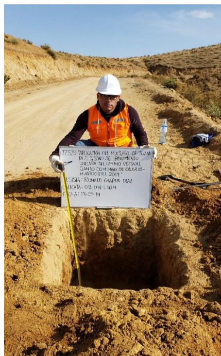
Foto N°7. Excavación de Calicata N°2 con una profundidad de 1.50m
