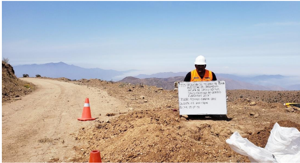
Foto N°9. Excavación de Calicata N°3 con una profundidad de d 1.50m
