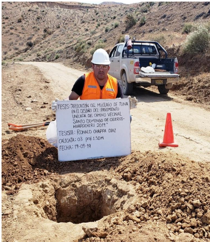
Foto N°10 Excavación de Calicata N°3 con una profundidad de 1.50m
