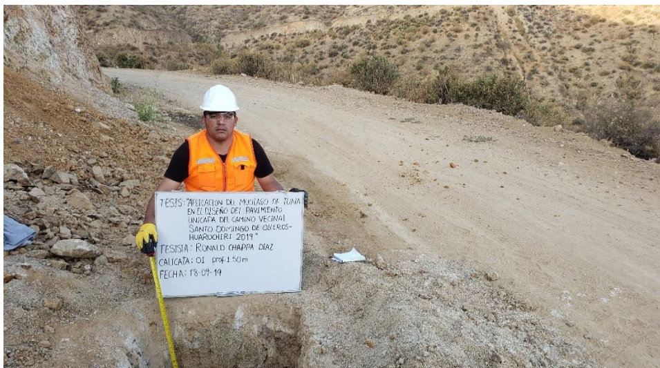
Foto N°3. Excavación de Calicata N°1 con una profundidad de 1.50m
