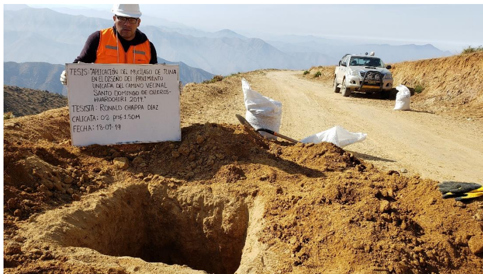
Foto N°6. Excavación de Calicata N°2 con una profundidad de 1.50m
