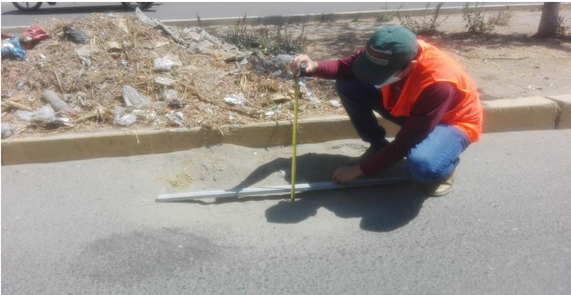
Figura 38. Abultamiento y hundimiento . Fuente: Elaboración propia.
