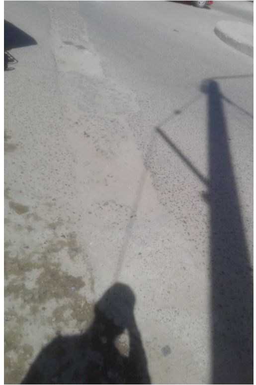
Figura 29. Depresiones longitudinales Fuente: Elaboración propia
