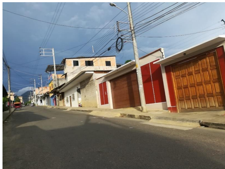
Figura 2: Se nota el tipo de viviendas que algunas están en buen estado y lo malo de esta vivienda, el cual se puede apreciar que están utilizando ventanas a lo que es a los costados.
