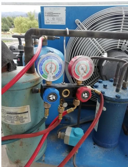
*Figura 20. Medición manométrica en unidad condensadora de la cámara de salmuera*
