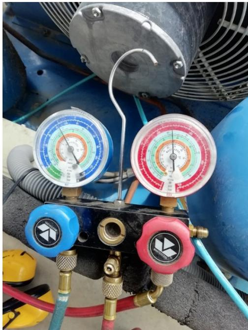
*Figura 18. Medición manométrica en unidad condensadora de la cámara de salmuera.*
