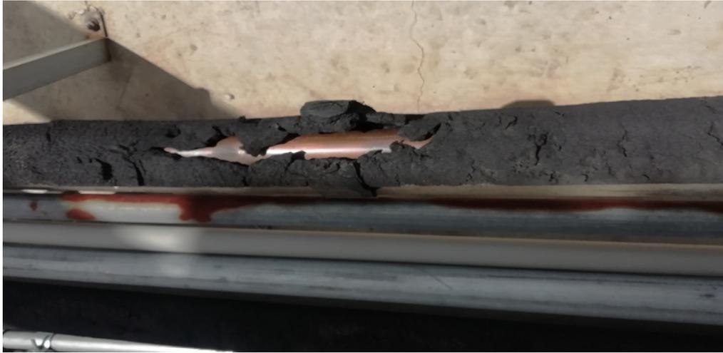
Figura 23. Aislamiento defectuoso en tramos de tuberías
