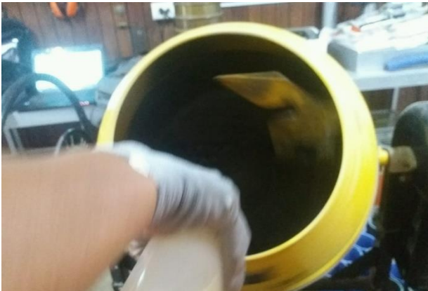
N° 38: Proceso de preparado de la mezcla (5).
