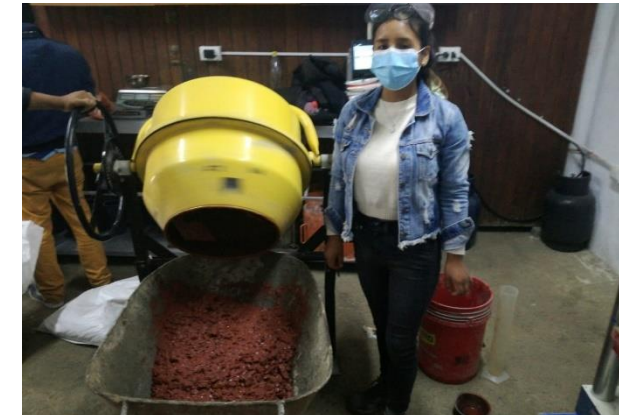
N° 39: Vaciado de la mezcla del concreto pigmentado rojo.
