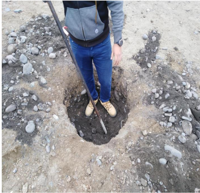
Foto 05: Excavando las siguientes calicatas
