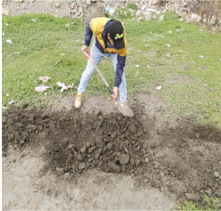
Foto 01: Inicio de excavación
