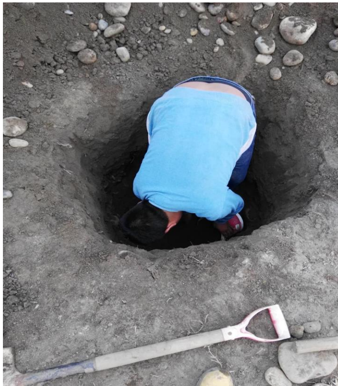
Foto 02: Profundidad de calicata
