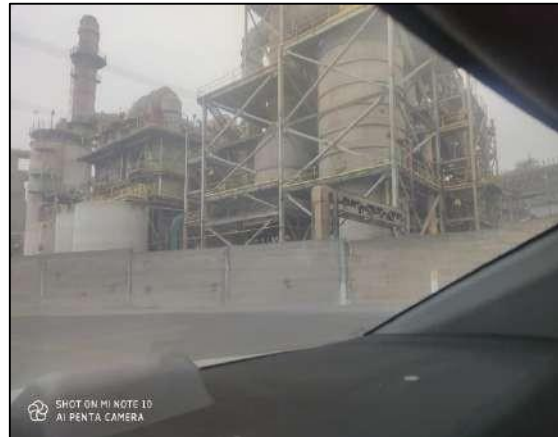
Planta de central térmica Ilo 21 - Moquegua
