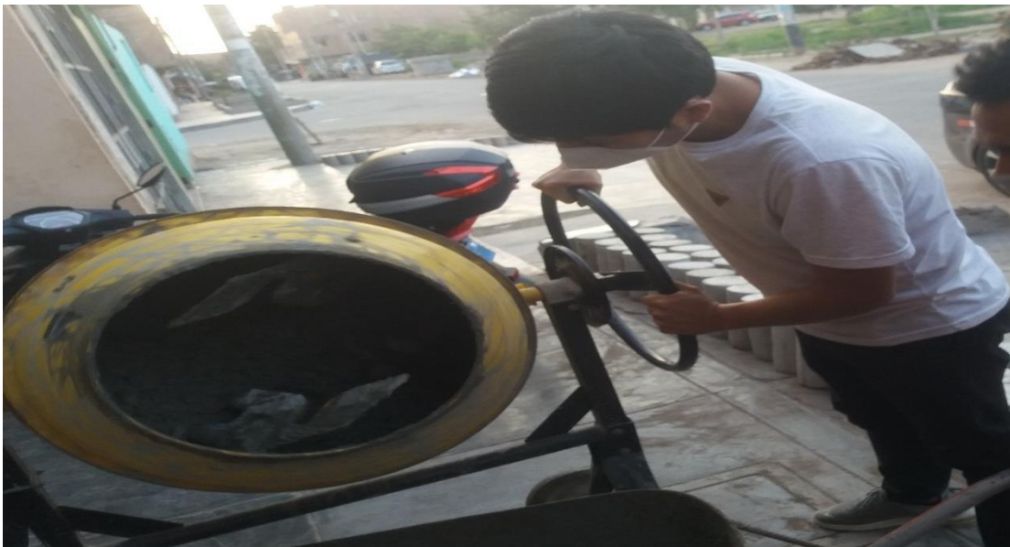
Figura 33: Inicio del vaciado de la mezcla del concreto.
