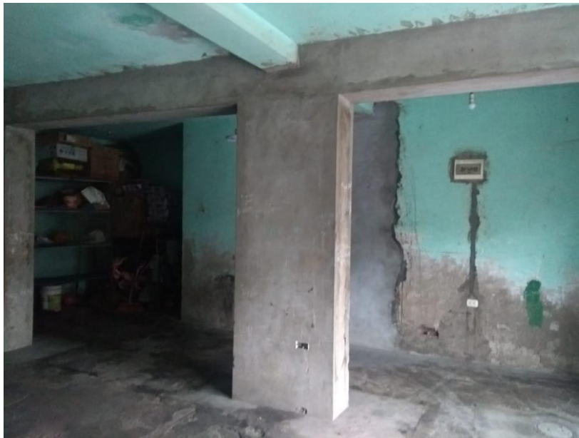
Imagen 7: Vista de la columna y vigas
