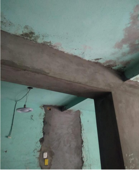
Imagen 9: encuentro entre columna y viga
