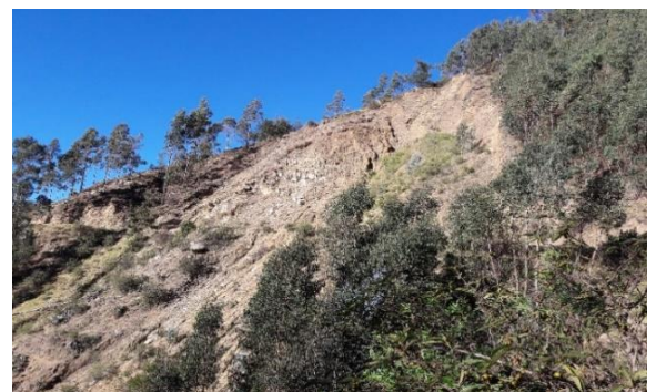
Figura 1.2. Foto km 27+560 al km 27+680 Fuente: Elaboración propia
