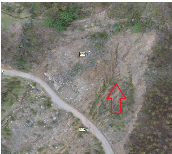
Figura 3.7. Talud en el tramo km 27+560 al km 27+680
