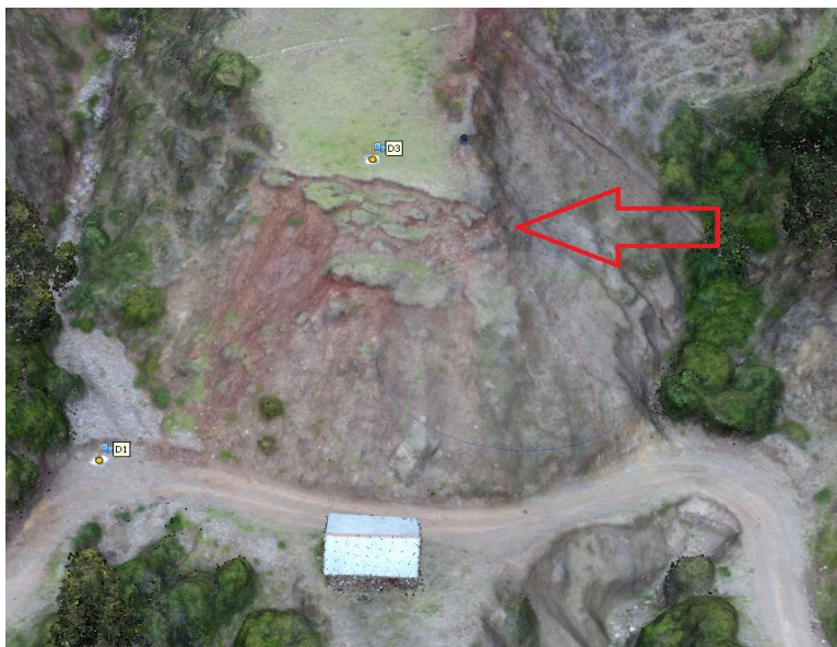
Figura 3.6. Talud en el tramo km 26+500 al km 26+640 Fuente: elaboración propia
