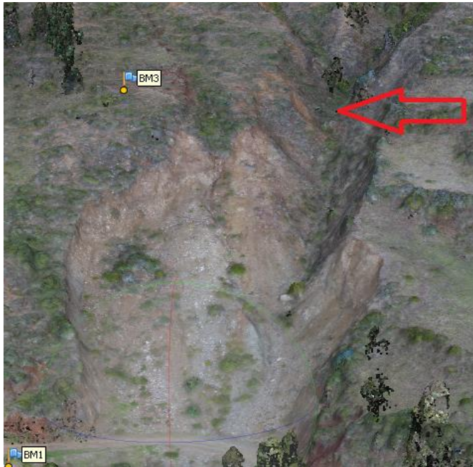
Figura 3.5. Talud en el tramo km 26+100 al km 26+140 Fuente: elaboración propia
