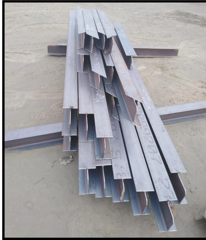
Anexo 9. Habilitado de elementos secundarios, proyecto Nueva refinería.
