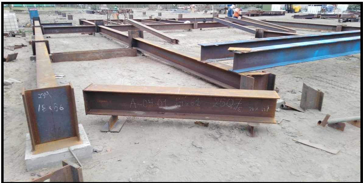
Anexo 10. Pre-montaje de plataformas, proyecto Nueva refinería.
