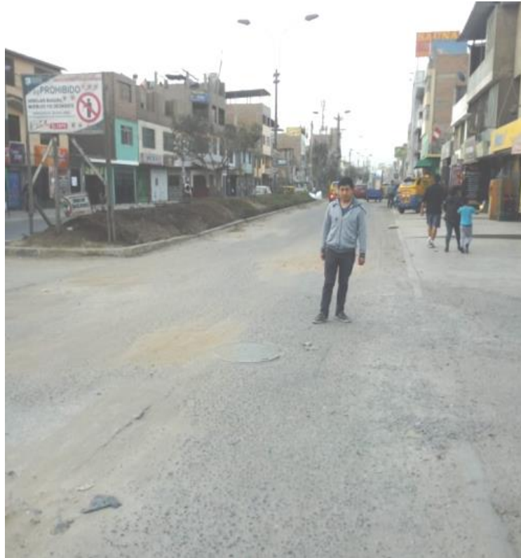
Figura 1. Estado actual de la avenida cesar Canevaro
