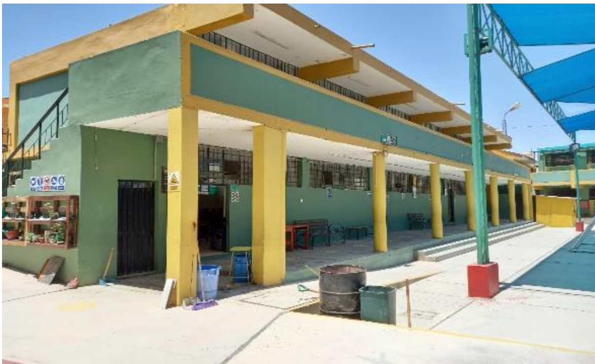
Figura 23. Pabellón P1 a evaluar vista interior
