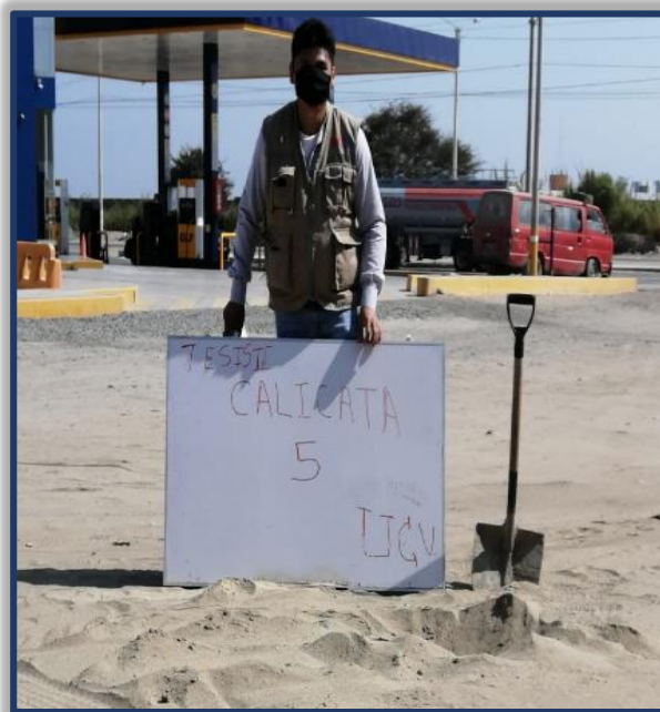
Figura N°07: Se procedió a realizar la calicata 5.
