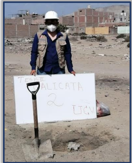
Figura N°04: Se procedió a realizar la calicata 2.
