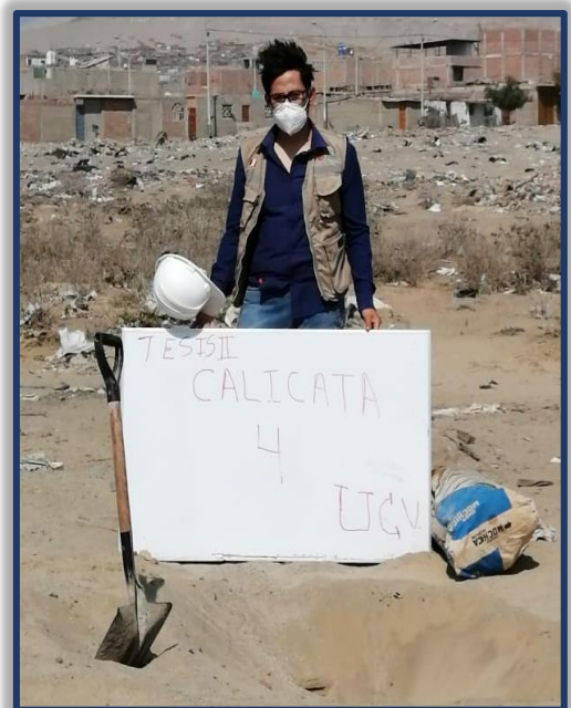
Figura N°06: Se procedió a realizar la calicata 4.
