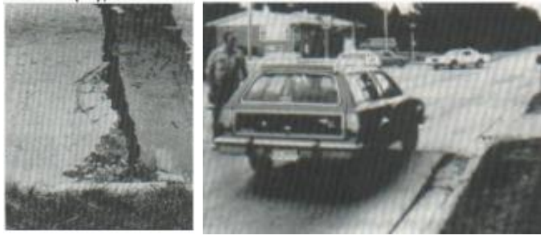
Figura 20. Levantamiento/Pandeo:
