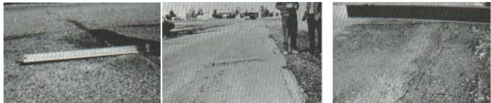
Figura 08. Abultamientos y Hundimientos
