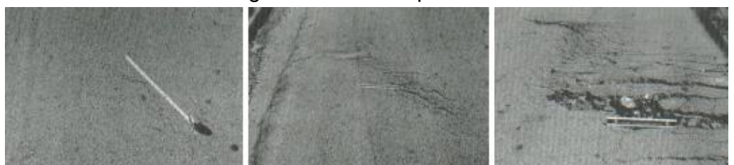
Figura 07. Grietas parabólicas
