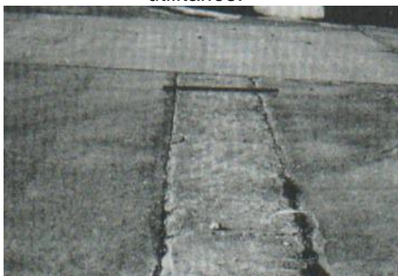
Figura 28. Parches grandes y parches grandes de cortes utilitarios:
