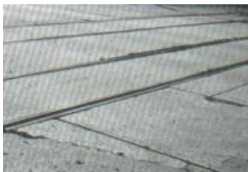
Figura 34. Cruce de vía férrea:
