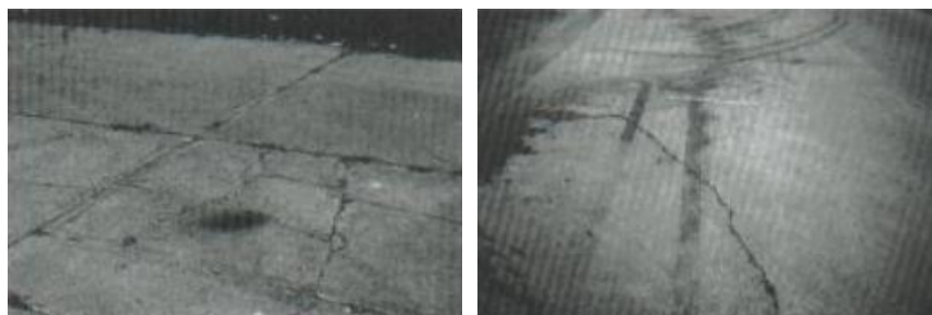
Figura 22. Losa dividida:
