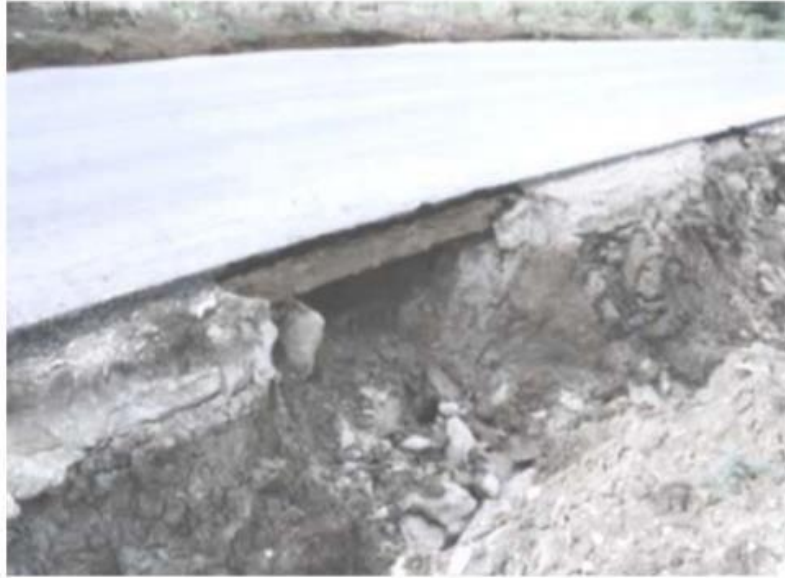
Figura 1: La capa estabilizada con cal soporta la erosión, ilustrando la resistencia
