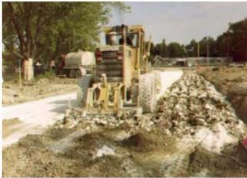
Figura 6: Escarificación después de haberse adicionado la cal
