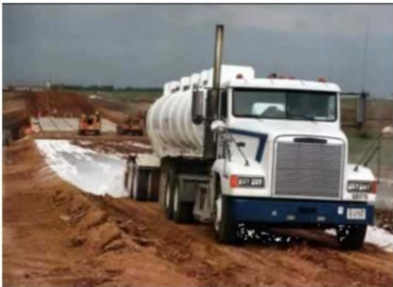
Figura 4: camellones utilizados para contener la cal antes de la mezcla.
