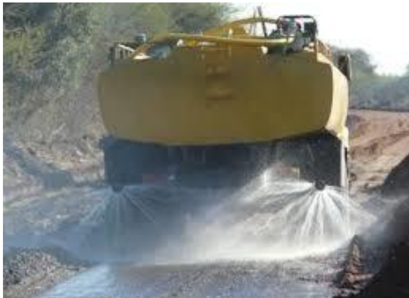
Figura 7: Adición de agua después de la escarificación y haberse adicionado la cal seca
