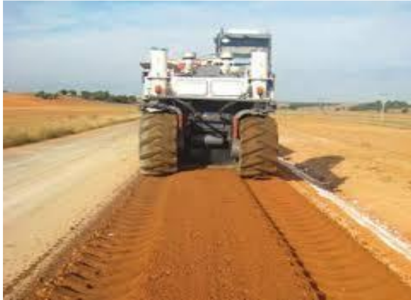
Figura 8: Estabilización de suelos para la homogenización inicial de los materiales.
