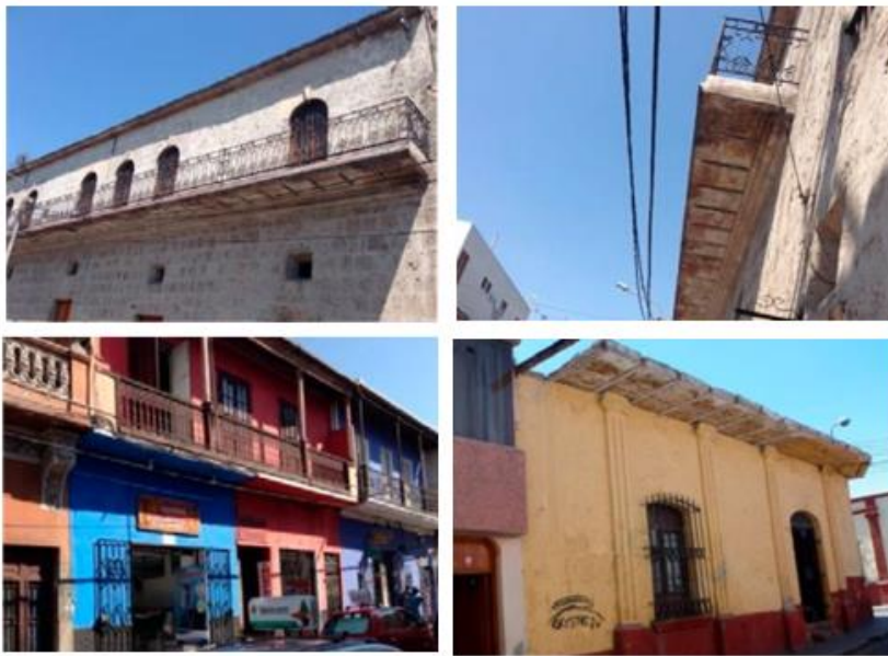
Figura 2: Edificaciones de la ciudad de Arequipa
