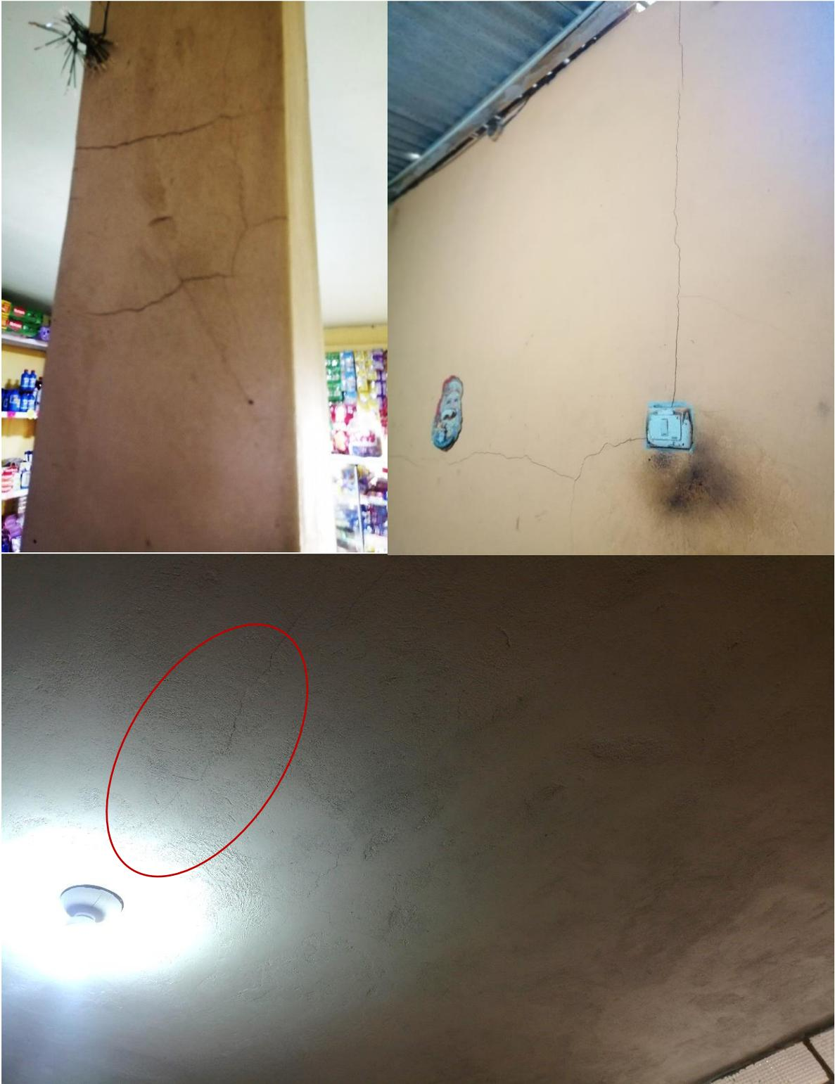
Presencia de grietas en columnas, losas, y muros.
