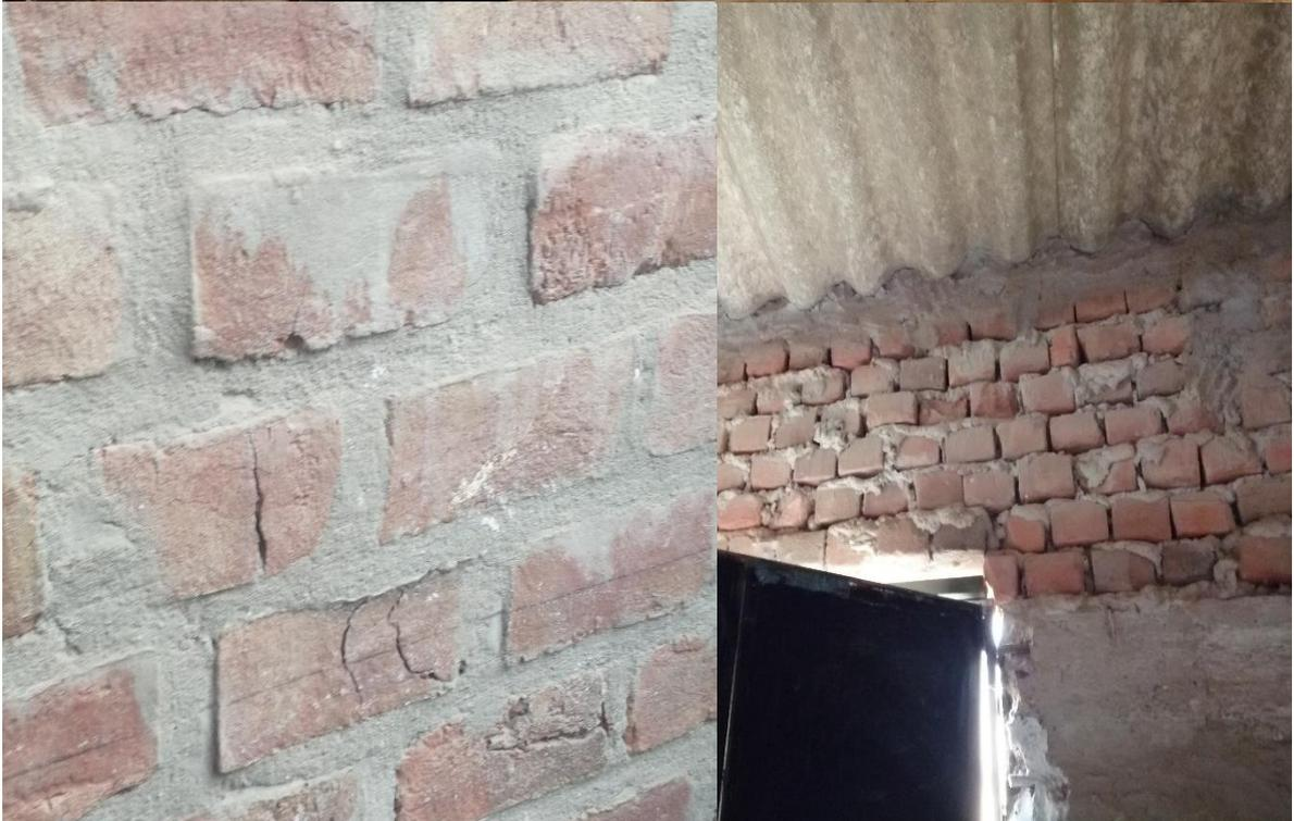
Unidades de albañilería de baja calidad y juntas de dilatación que no cumplen con el espesor mínimo establecido por la norma E.070.
