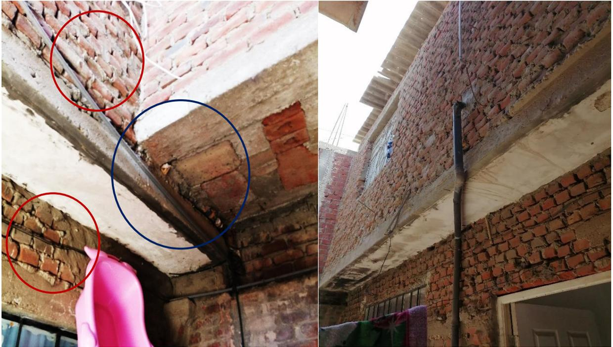
Desnivel de losas, unidades de albañilería de baja calidad y no uniformes con presencia de un mortero de baja calidad.
