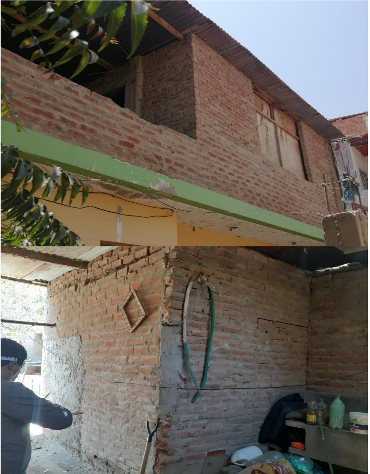
Muros sin presencia de elementos de confinamiento.
