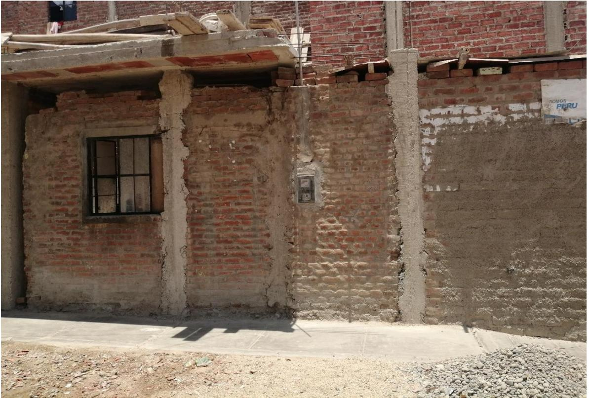
Muros conectados inadecuadamente con los elementos de arriostre.
