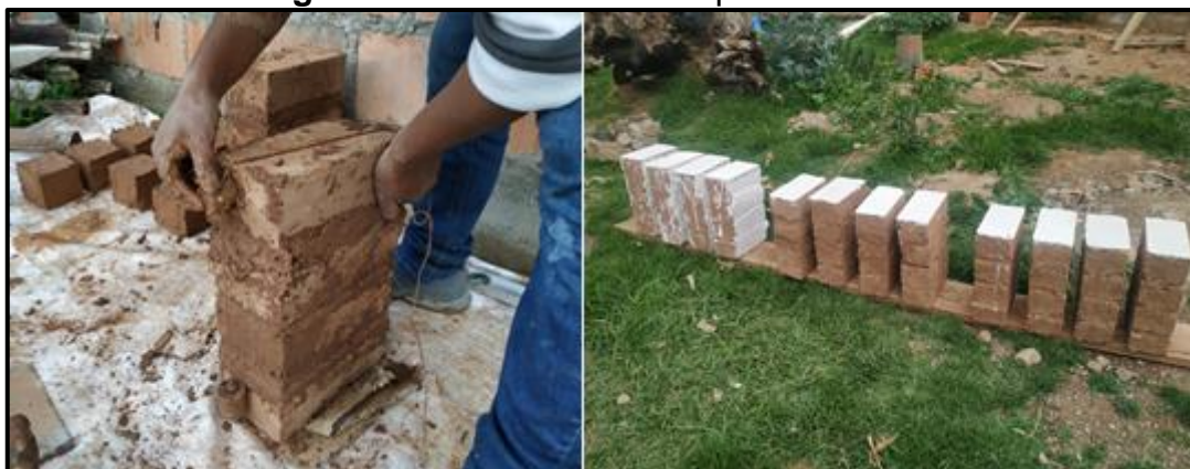
Figura 23: Elaboración de pilas de adobe
