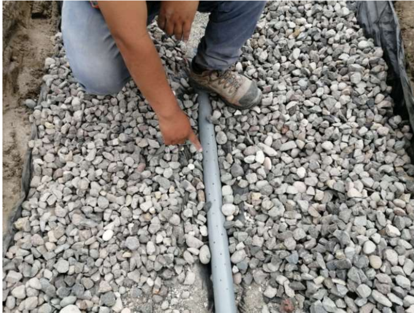
Fig. 50: Colocación de tubería perforada en geomembrana.
