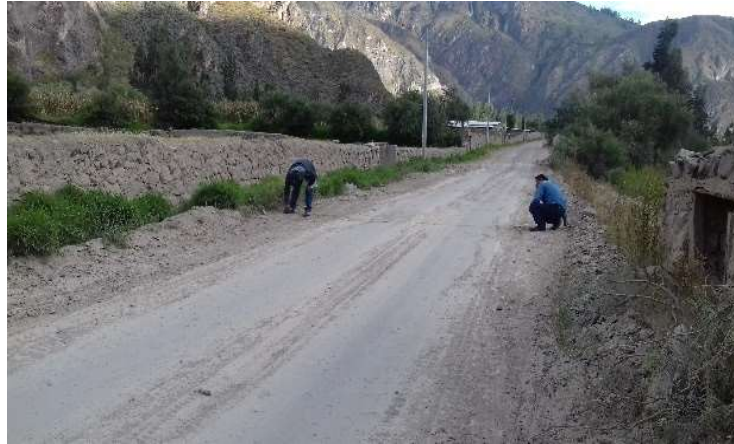
Fig. 6: Medición de ancho de vía
