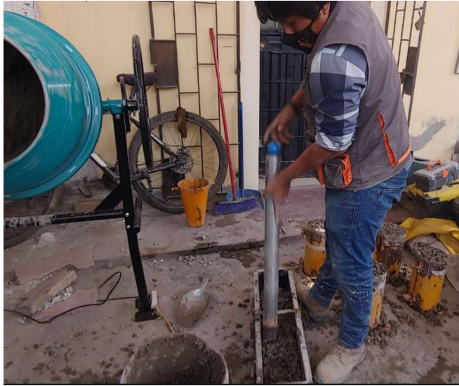
Fig. 27: Compactado de vigas de concreto permeable.
