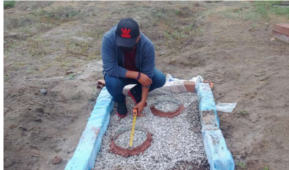
Fig. 53: Instalación del anillo de infiltración.
