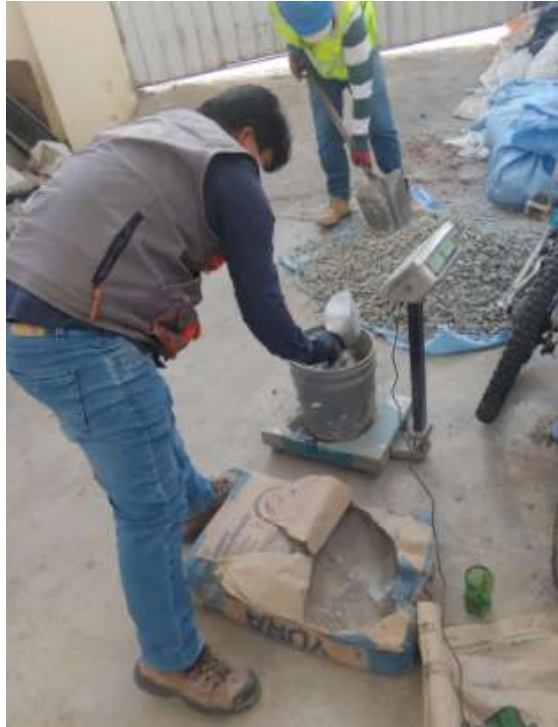
Fig. 25: Medición de insumos para la elaboración del concreto permeable.
