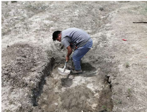
Fig. 49: Perfilado de la rasante del prototipo.
