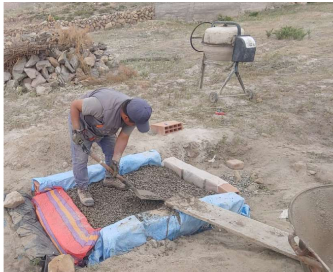
Fig. 52: Vaciado del prototipo del concreto permeable.
