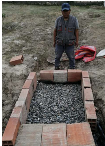
Fig. 51: Delimitado de área para vaciado de concreto permeable.
