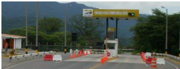
Ilustración 45. UNIDAD DE PEAJE LOMA LARGA BAJA EN LA CARRETERA EMPALME 1B - CANCHAQUE
