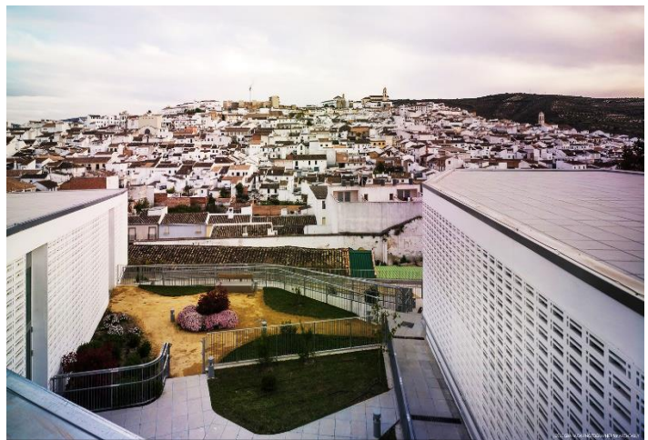
Figura 26: Acceso a las terrazas por rampas
