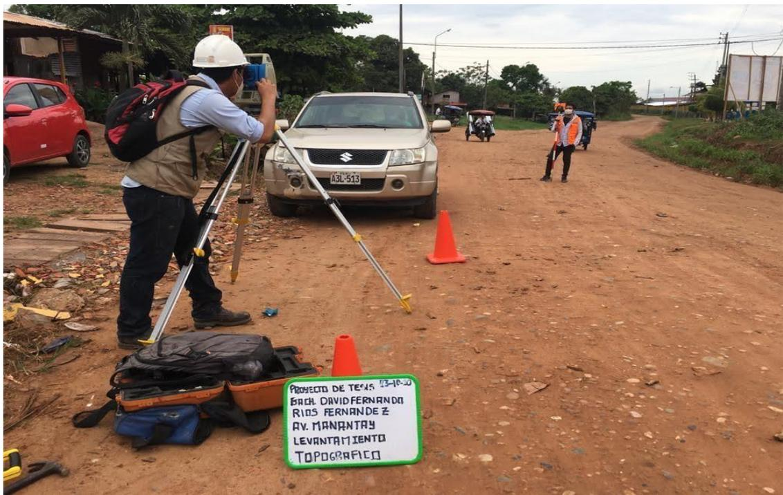
Fotografía 2. Levantamiento topográfico de la Av. Manantay, vista de la vía.
