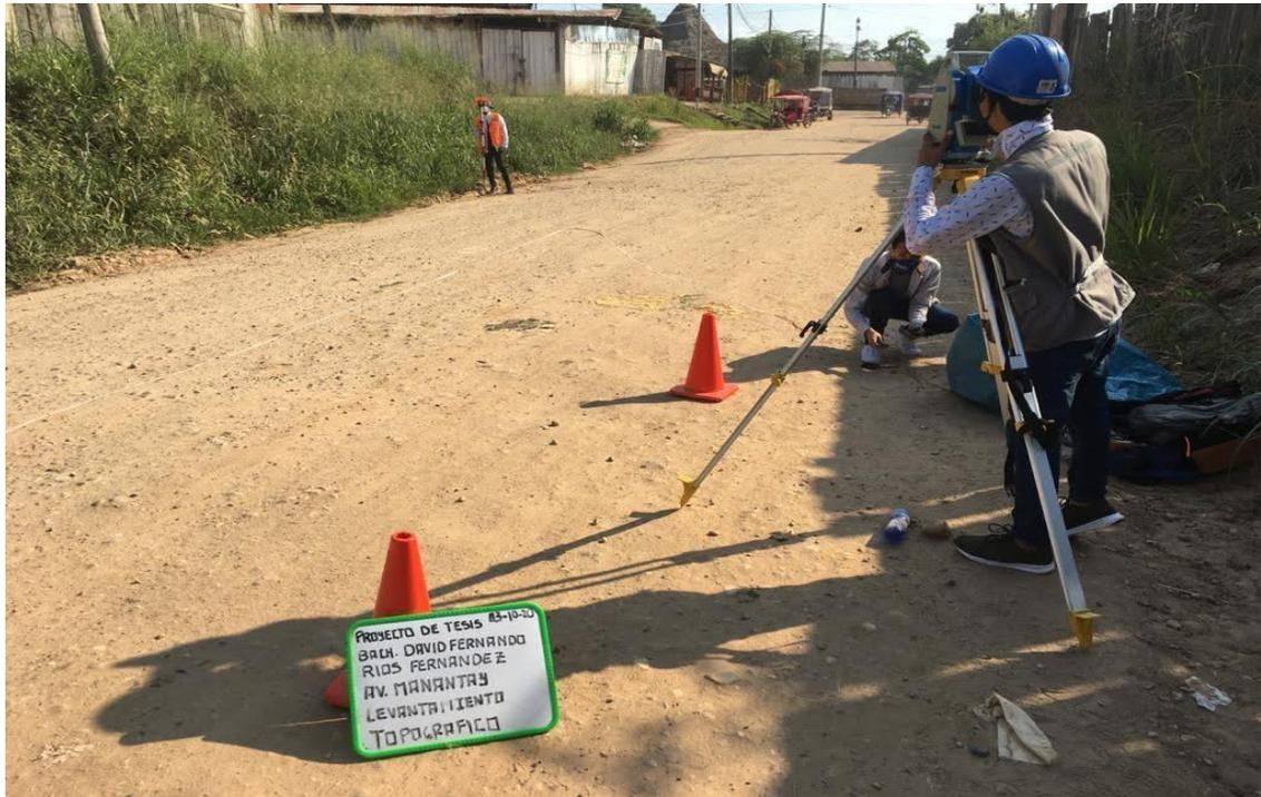
Fotografía 1. Levantamiento topográfico de la Av. Manantay, vista de la primera cuadra.
