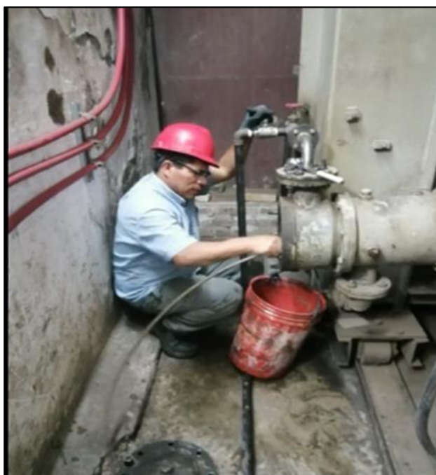
Figura 18. Revisión de líneas de refrigeración del turbo
