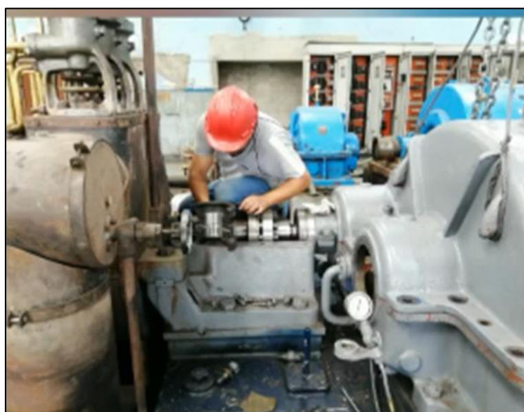
Figura 16. Revisión general del acoplamiento del turbo - generador
