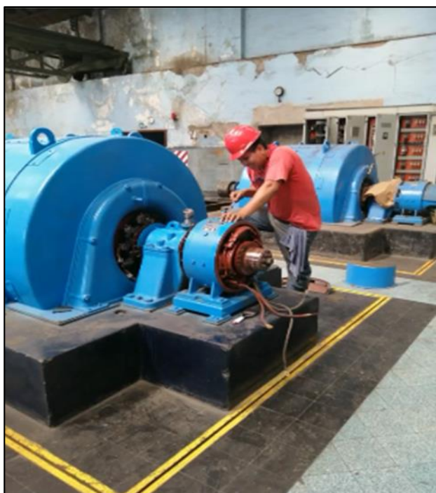
Figura 17. Mantenimiento del generador eléctrico
