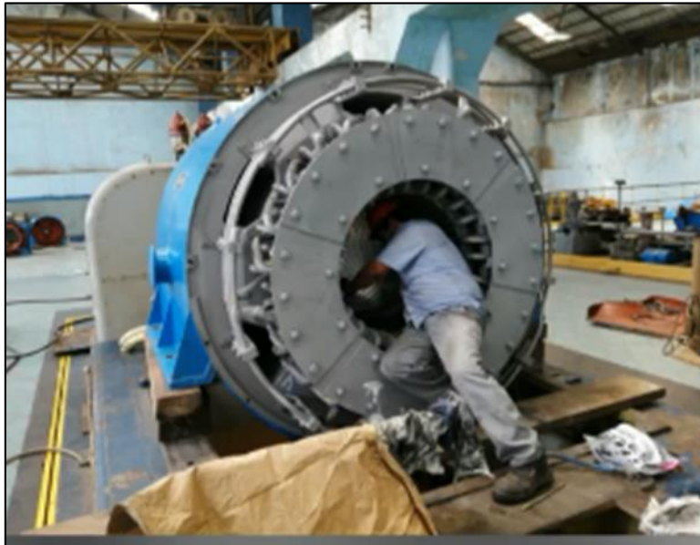
Figura 22. Reparación general del generador del turbo
