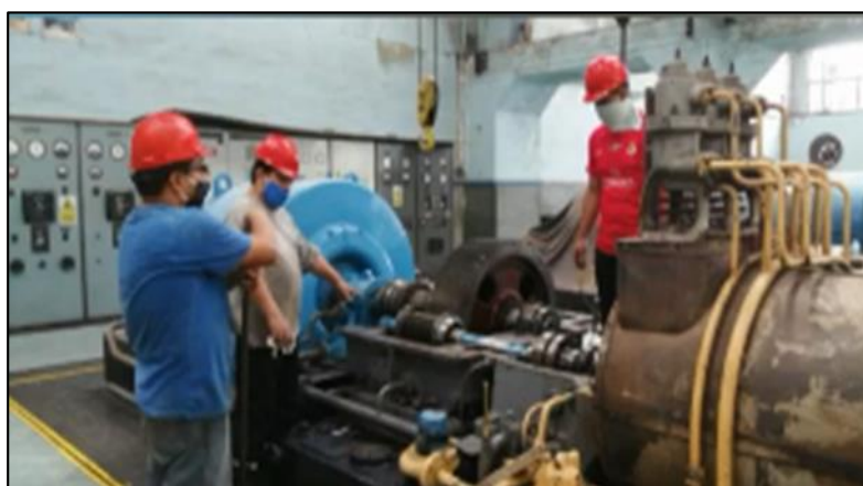
Figura 15. Mantenimiento del reductor de la turbina
