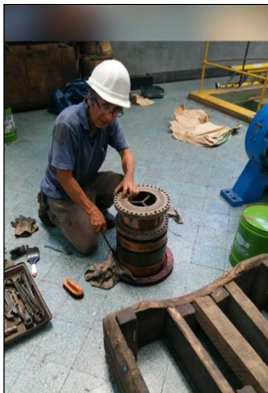
Figura 23. Reparación general de pieza del turbo.
