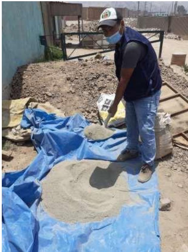
Figura 45: Preparación del mortero para la construcción de muretes y pilas, dosificación 1:4.
