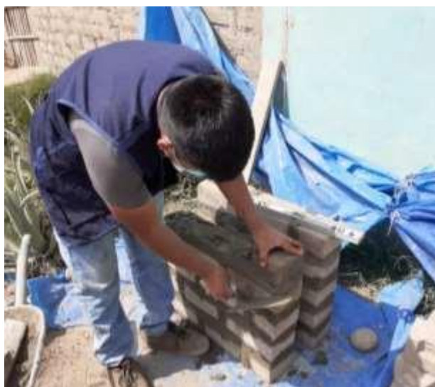
Figura 12: Construcción de muretes
