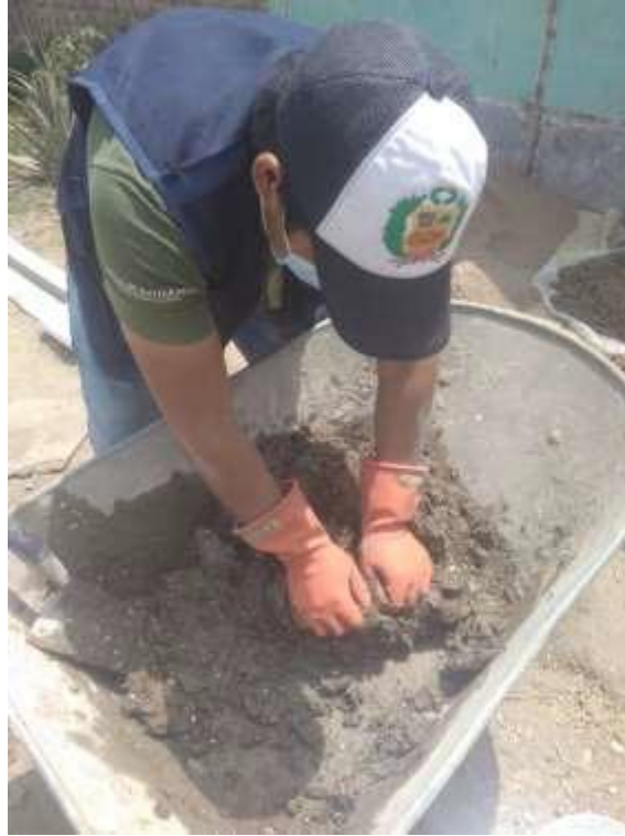
Figura 40: Amasado de la arcilla, cemento y plástico PET.
