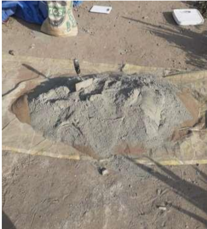
Figura 38: Proceso de mezclado en seco de arcilla, cemento y plástico PET.
