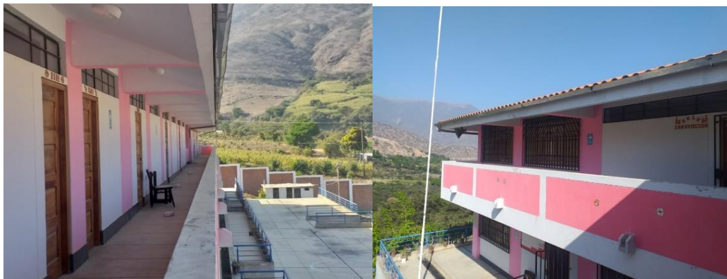
Figura 72. Tipo de cubierta de la I.E. “7 de Junio”
