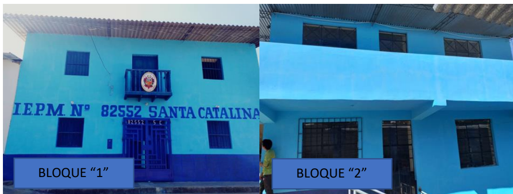
Figura 76. Elementos no estructurales de la I.E.P.M. N°82552
