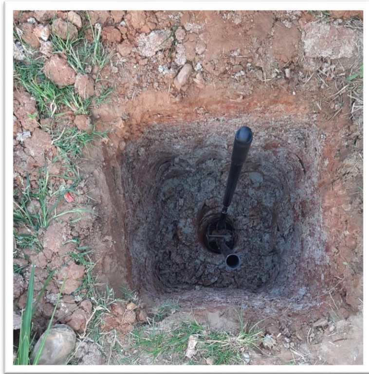
Calicata de 1.5 m de profundidad.
