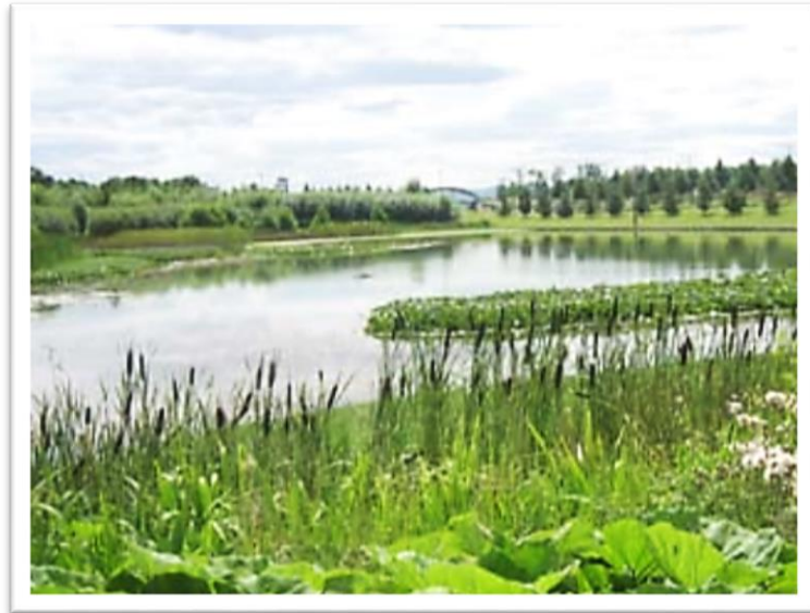
Figura 13. Estanque de retención
