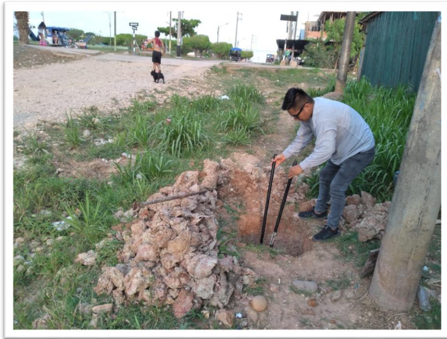
Extracción de segunda capa de suelo
