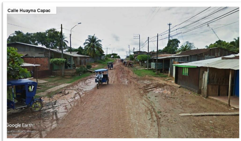
Calle Huayna Cápac enlodada y con dificultad para transitar.
