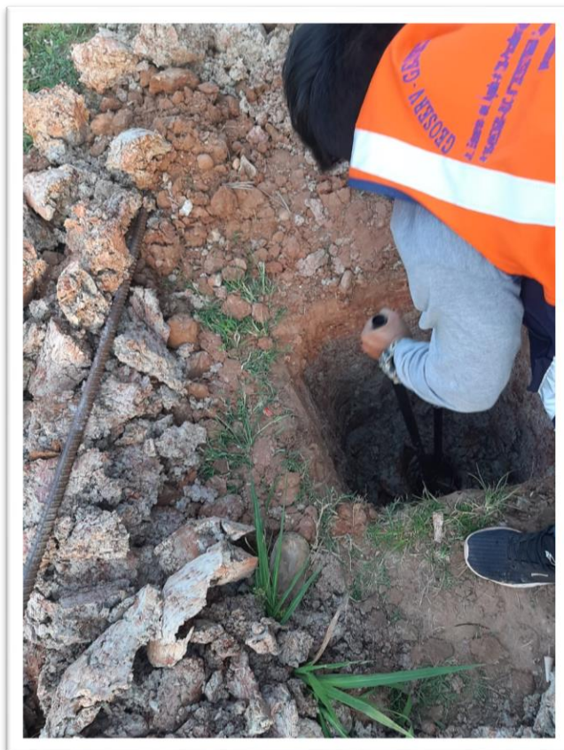
Excavación de calicata hasta 1.5 m.
