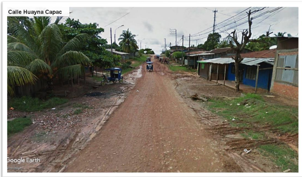
Rastros de escorrentía en la Calle Huayna Cápac.
