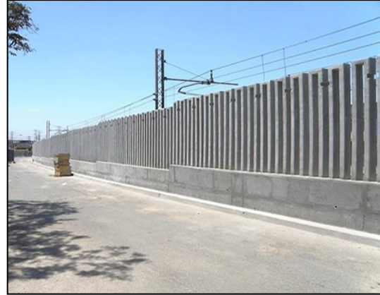
Figura 11: Modelo de cerco tipo UNI.
