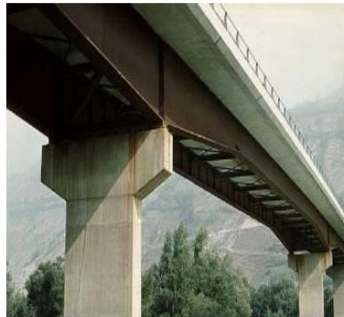
Puente mixto de acero y hormigón armado
