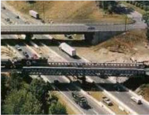
Puente Caminero y Puente Ferroviario
