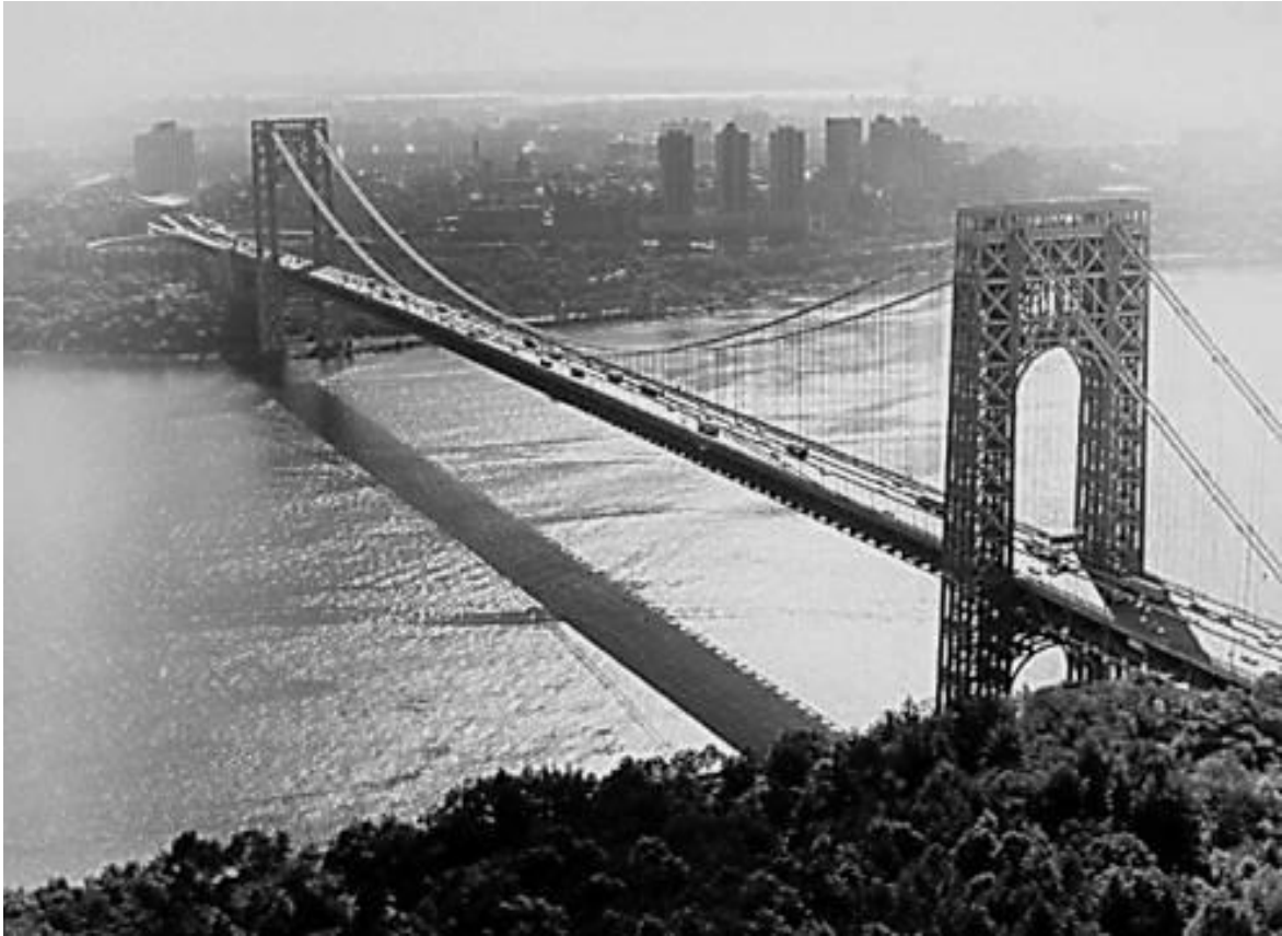
Figura 3. Puente George Washington
