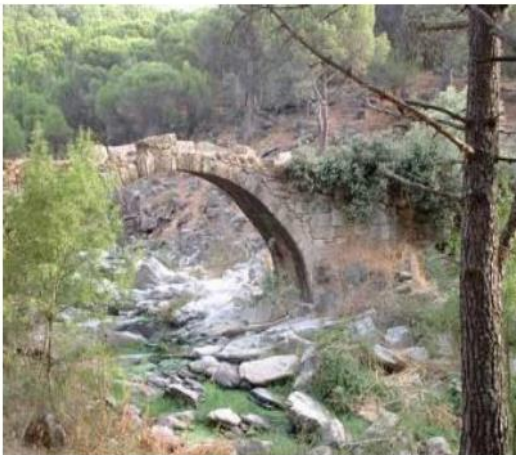
Puente de mampostería de piedra
