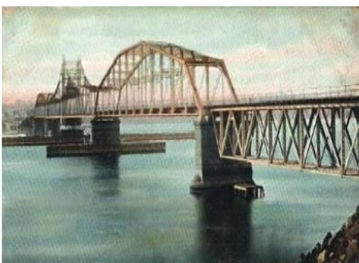
Puente de Draw construido en New London con tablero inferior y superior
