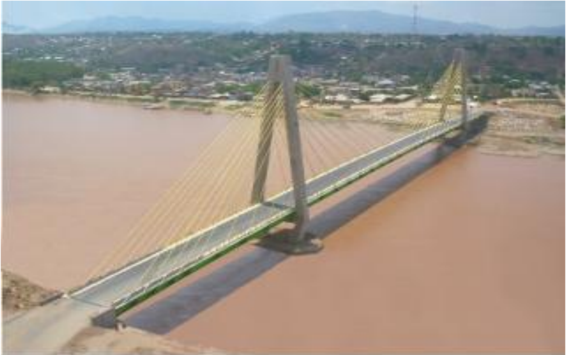
Puente “Bellavista” Atirantado ubicado en la Región San Martín- Perú.
