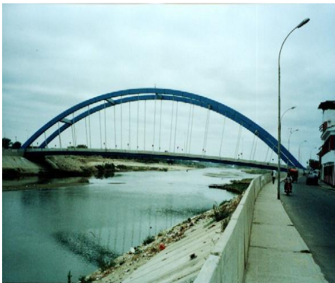
Puente en Arco Simplemente apoyado
