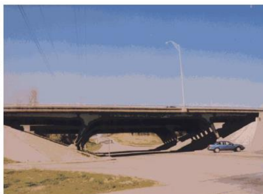
Puente conformado con un pórtico metálico con pilares inclinados. Oklahoma (USA).
