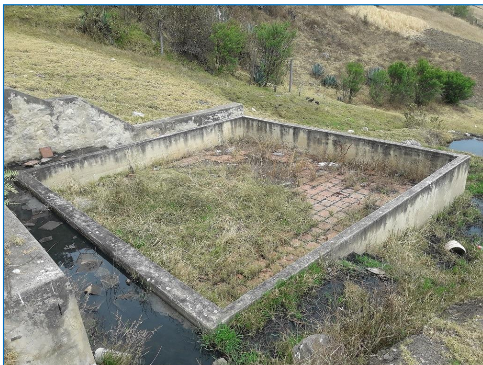
Figura N° 12 - Vertedero en mal estado
