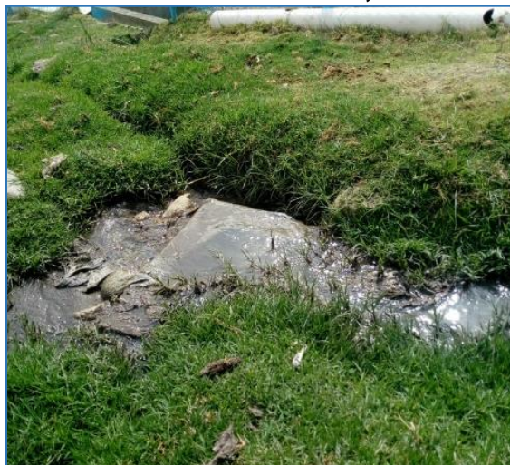
Figura N° 2 – Evaluación del canal de entrada, desarenador y canal Parshall
