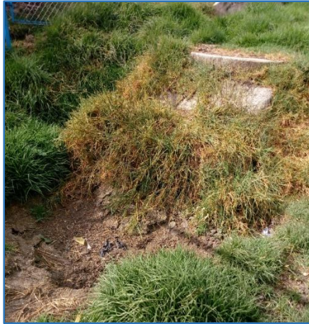
Figura N° 6 - Evaluación de la cámara de contacto con cloro
