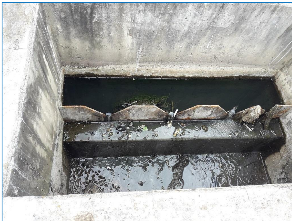
Figura N° 12 - Vertedero en mal estado
