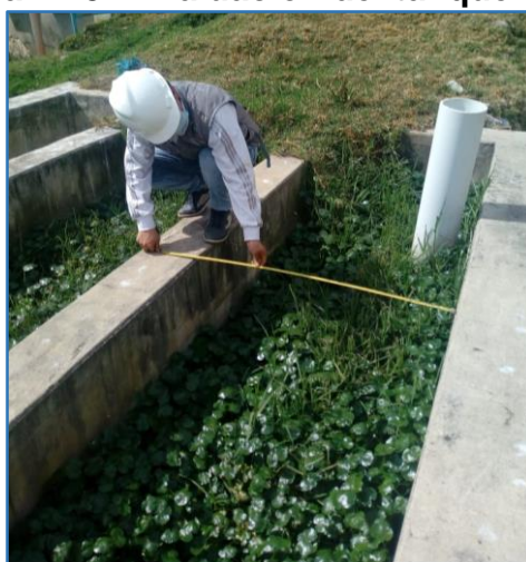
Figura N° 3 - Evaluación del tanque Imhoff
