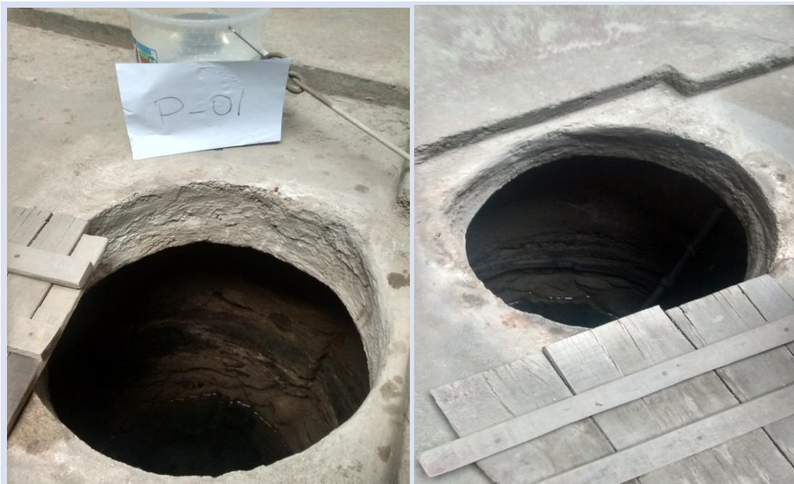
Anexo 6: Pozos de agua subterránea - Vivienda N°1 – Mz.L Lt 5.
