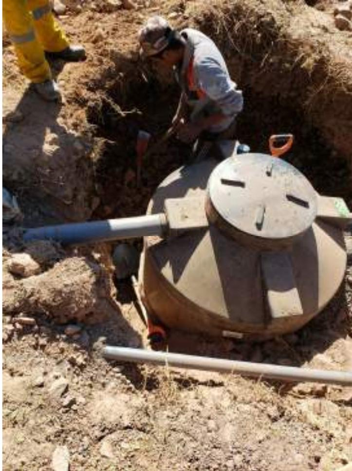
*Figura 58.* En la fotografía se muestra la excavación para colocación del biodigestor en terreno rocoso (roca suelta).
