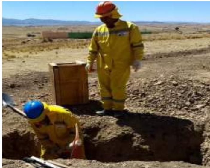
*Figura 44.* Excavación para biodigestor.
