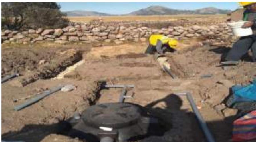
*Figura 48. Instalación de tuberías y accesorios p/percolación o infiltración*
