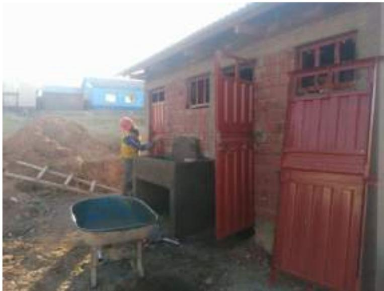
*Figura 59.* En la fotografía se muestra la colocación de puertas metálicas en MBS.
