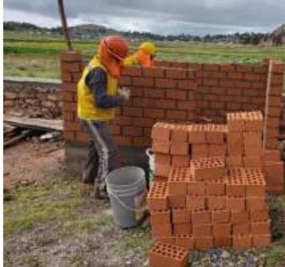
*Figura 38. Asentado de muro caravista de la caseta sanitaria*
