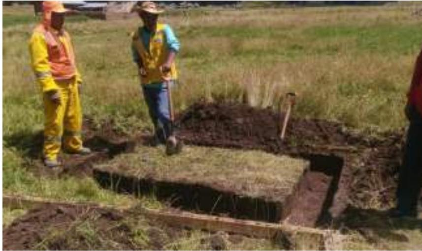
*Figura 32. Excavación para cimiento corrido de caseta sanitaria*
