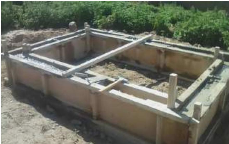
*Figura 35. Vaciado de concreto para sobrecimiento de la caseta sanitaria*
