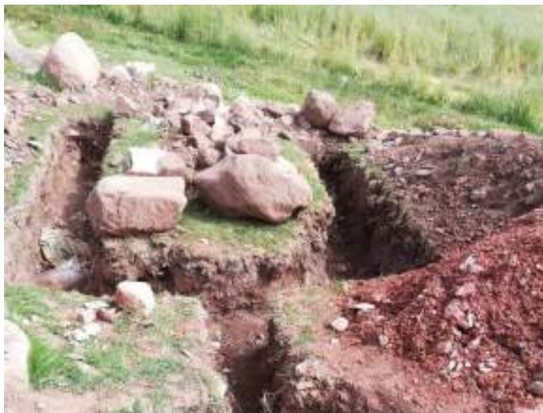
*Figura 57.* En la fotografía se muestra la excavación para zanjás de infiltración en terreno rocoso (roca dura).
