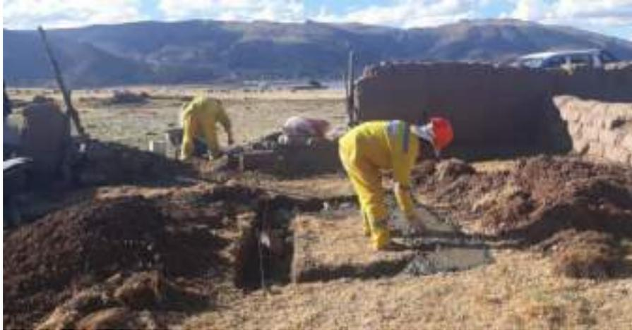
*Figura 34. Vaciado de cemento corrido de la caseta sanitaria.*
