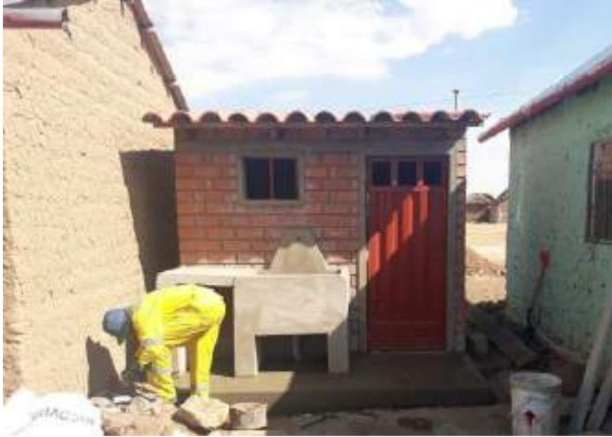
*Figura 40.* Vaciado de concreto para piso de la caseta sanitaria.
