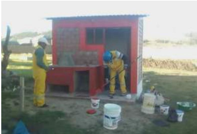
*Figura 42.* Pintura en muros interiores y exteriores de la caseta sanitaria
