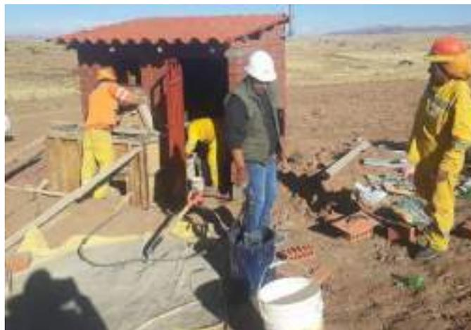
*Figura 43.* Vaciado de concreto  $F'c=175\text{kg/cm}^2$  para lavatorio.
