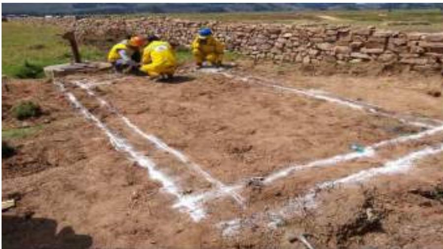
*Figura 31. Trazo y replanteo para caseta sanitaria.*
