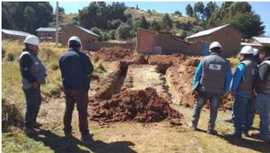
*Figura 56.* En esta fotografía de muestra los trabajos para Zanjas de Infiltración.
