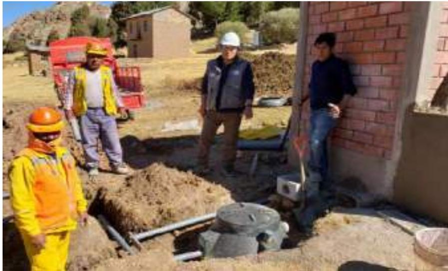
*Figura 47. Instalación de biodigestor*
