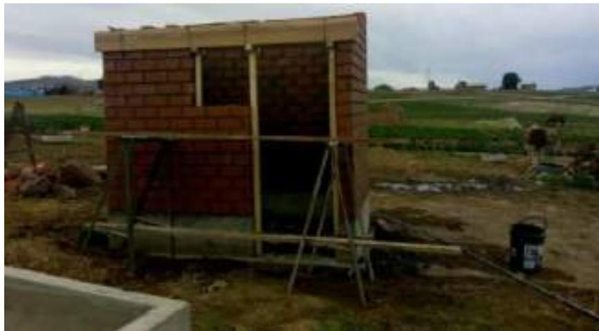
*Figura 37. Vaciado de concreto para dintel de caseta sanitaria*
