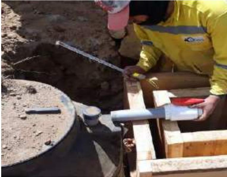
*Figura 45. Encofrado y desencofrado para caja de lodos.*
