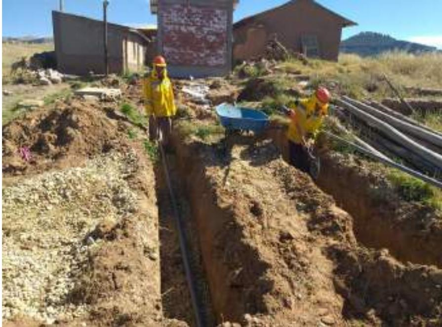
*Figura 55.* En esta fotografía de muestra los trabajos para Zanjas de Infiltración.
